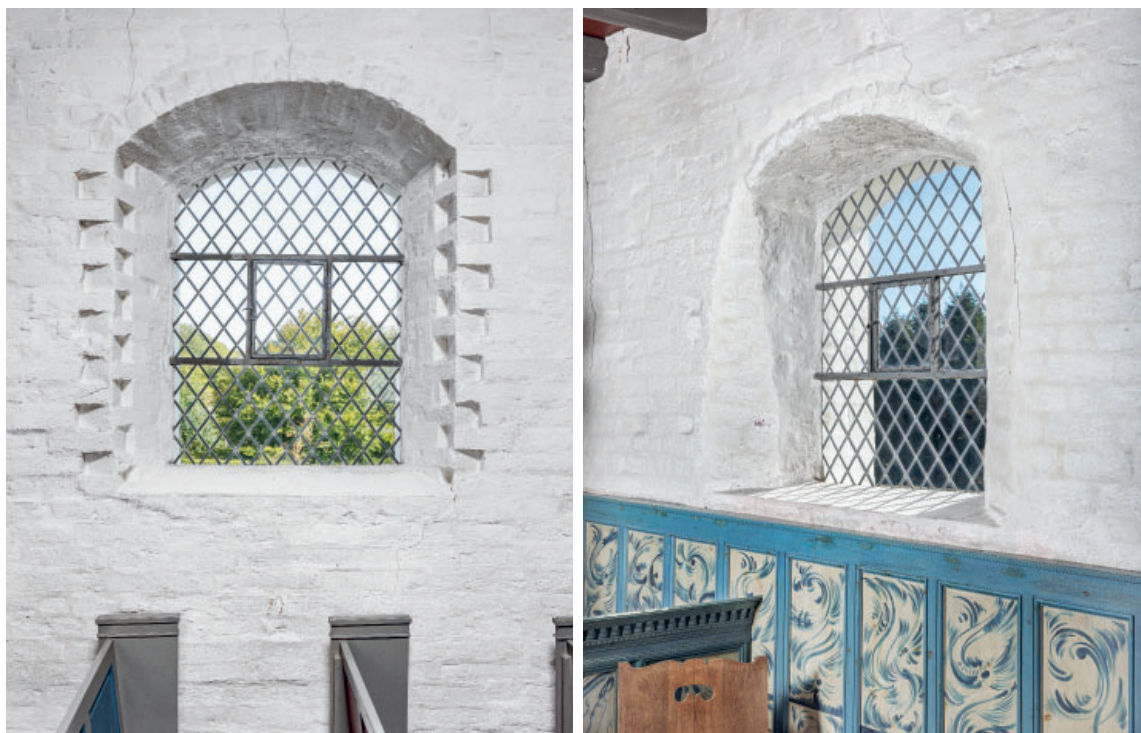
Fig. 14-15. Senmiddelalderlige vinduer østligt i skibets nordmur og i korets sydmur (s. 6925). Foto Arnold Mikkelsen 2024 og 2023. – Late Medieval windows to the east in the nave's north wall and in the chancel's south wall.
