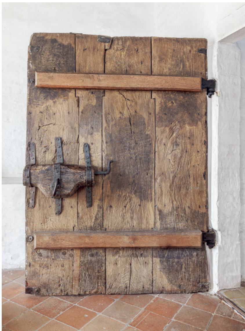
Fig. 57. Bagside af jernbunden dørføj 1505, med bladede samlinger af plankerne (s. 6961, jf. fig. 58). Foto Arnold Mikkelsen 2024. – The back of the iron-bound door wing, 1505, the planks joined in splice joints.
