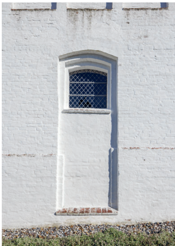
Fig. 18-19. Vestforlængelsens tilmurede vestdør, ydre og indre (s. 6926). Foto Arnold Mikkelsen 2023. – Bricked-up west door of the western extension, exterior and interior.
