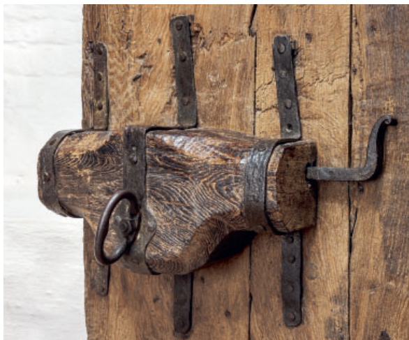
Fig. 59-60. 59. *Nøgle til jernbunden dørfløj 1505 (s. 6964). I Humlemagasinet, Harndrup. Foto Arnold Mikkelsen 2023. 60. Kasselås på jernbunden dørfløj 1505 (s. 6962, jf. fig. 57). Foto Arnold Mikkelsen 2022.— 59. *Key to iron-bound door wing, 1505. 60. Rim lock on iron-bound door wing, 1505.
