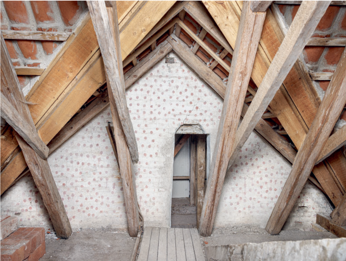
Fig. 29. Tårnets oprindelige nordfacade med kalkmalede, røde prikker (s. 6937). Foto Arnold Mikkelsen 2024. – The tower's original north facade with painted red dots.
