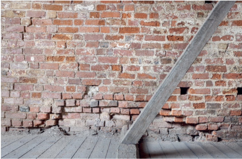
Fig. 20. Hvælvforlæg i vestforlængelsens taggavl (6926). Foto Arnold Mikkelsen 2024. – Filled-in remains in the western extension's gable of an unfinished vault.
