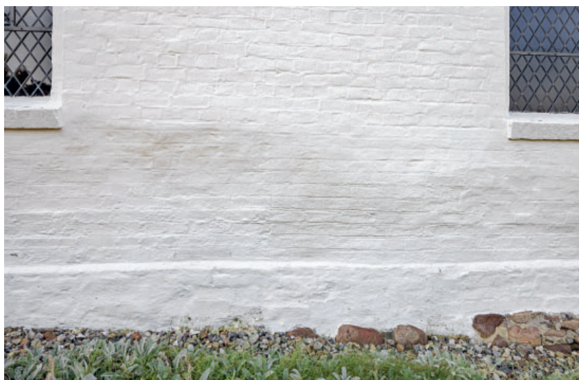
Fig. 11. Den tilmurede romanske norddørs ydre (s. 6925). Foto Arnold Mikkelsen 2024. – Exterior of the bricked-up Romanesque north door.
