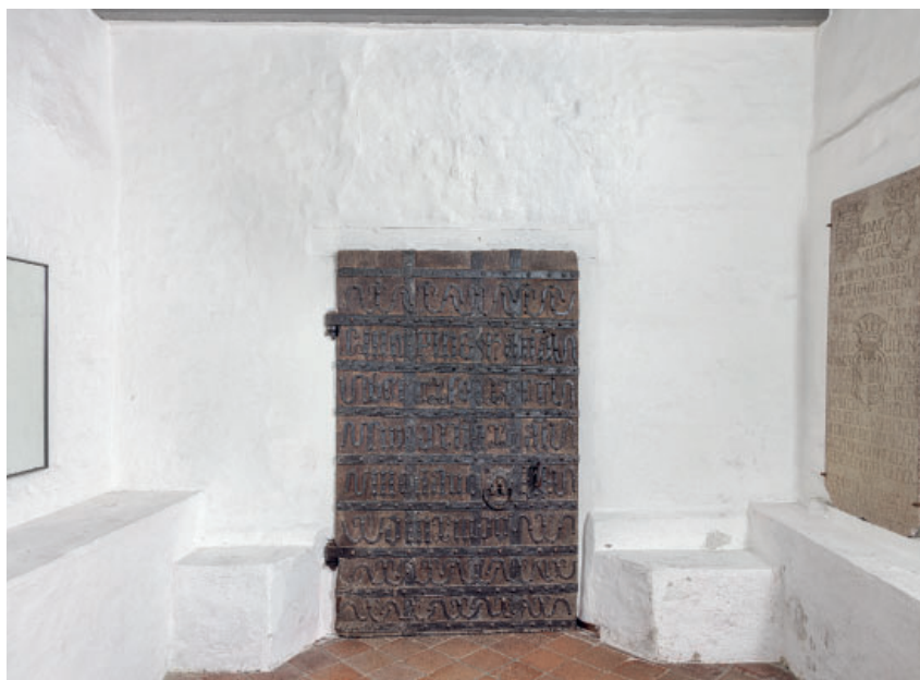
Fig. 61. Skibets syddør set fra våbenhusets indre med jernbunden dørfløj (s. 6961, jf. fig. 58). Foto Arnold Mikkelsen 2023. — South door of the nave seen from the porch with iron-bound door wing.
