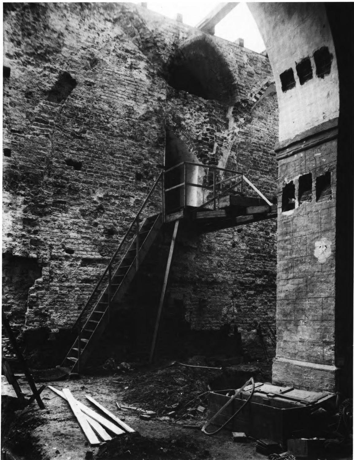
Fig. 34. Vestre del af søndre sideskibsmur (sml. fig. 14). Der ses spor efter hvælvforlæg i kirke nr. 1-2, et vindue fra kirke nr. 2 (sml. fig. 16) og rester af (de midlertidigt fjernede) hvælv i kirke nr. 3 (sml. s. 722). — Westlicher Teil der Südmauer des Seitenschiffs. Man sieht Spuren von Gewölbeforlagen der Kirchen Nr. 1-2, ein Fenster der Kirche Nr. 2 (vgl. Fig. 16) und Reste der (vorübergehend entfernten) Gewölbe der Kirche Nr. 3.
