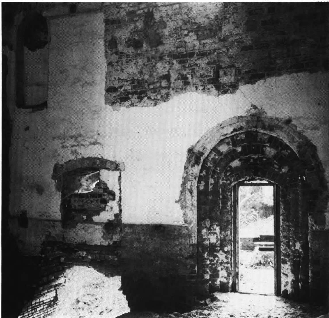
Fig. 19. Søndre sideskibsmur, 3. fag fra øst (sml. fig. 14). Den rundbuede, falsede dør til klostrets \dagger østfløj har været i brug fra den ældste kirkes tid (s. 701). Den højtsiddende dør til østfløjens øvre etage (dormitoriet) hører snarest til kirke nr. 2. Nørgaard Nielsen fot. 1918. — Südliche Seitenschiffsmauer, 3. Fach von Osten. Die gefalzte, rundbogige Tür zum Ostflügel des Klosters ist seit der Zeit der ältesten Kirche in Gebrauch. Die hochgelegene Tür zum oberen Stock des Ostflügels (dem Dormitorium) dürfte eher zur Kirche Nr. 2 gehören.
