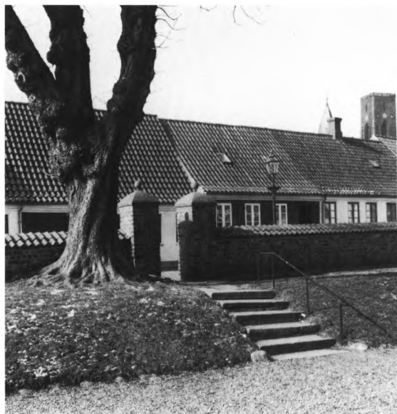
Fig. 8. Kirkegårdsmuren og portalen mod Kloster-gade. Trappen består af kasserede gravsten (s. 692, 779, 791). EN fot. 1984. — Friedhofsmauer und Portal zur Klostergade. Die Treppe besteht aus ausrangierten Grabsteinen.
