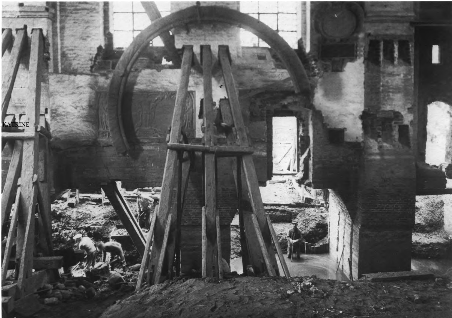
Fig. 37-38. Kirkens østgavl afstivet under arbejdet med de nye fundamenter 1918 (s. 720). Nørgaard Nielsen fot. — Der Ostgiebel der Kirche, abgestützt während der Arbeit am neuen Fundament 1918.
