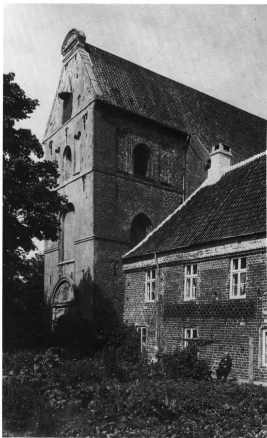
Fig. 39. Tårnet og klostrets vestfløj før restaureringen 1918-32 (sml. fig. 32). Hude fot.? — Turm und Westflügel des Klosters vor der Restauration von 1918-32.
