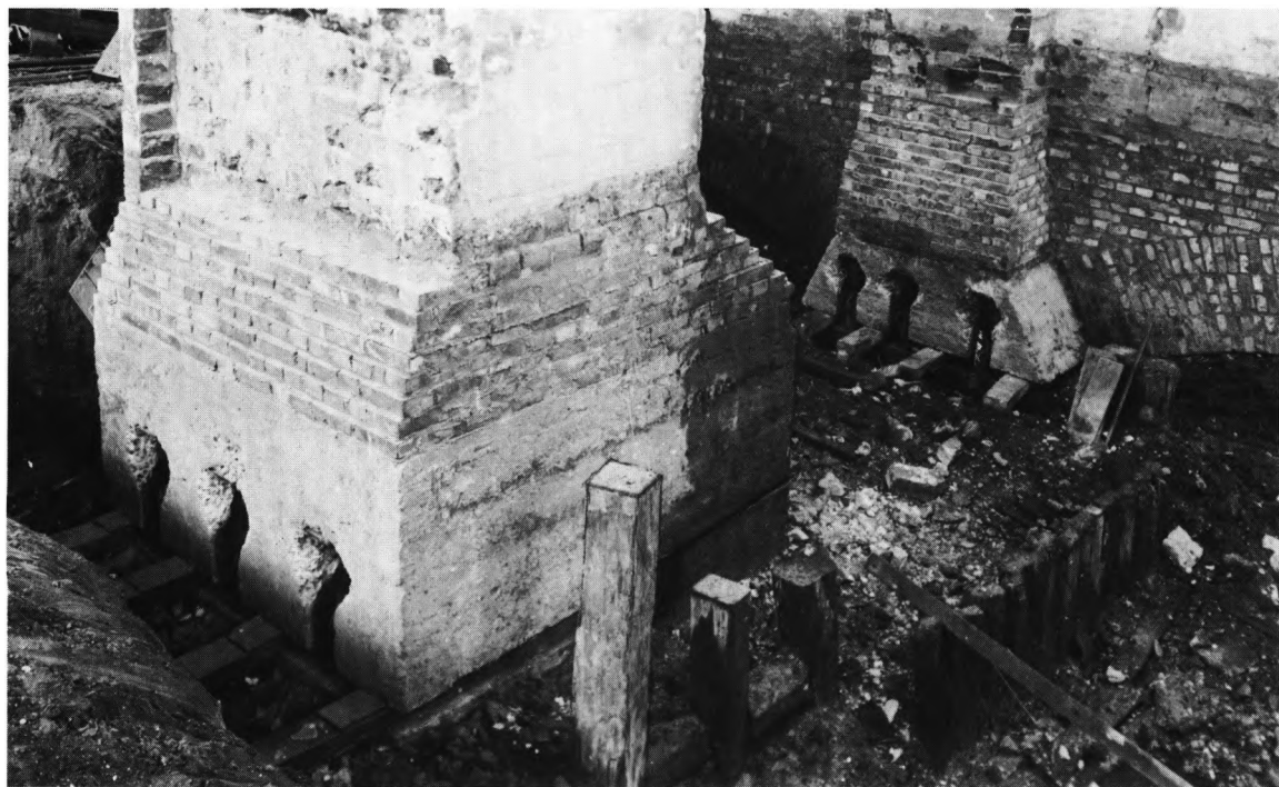
Fig. 36. Kirkens opretning 1920 (s. 720). En sektion af »vippeanordningen« (sml. A på fig. 35), der bragte de hældende langmure tilbage i lodret stilling. Nørgaard-Nielsen fot. 1920. — Aufrichtung der Kirche 1920. Ein Teil der »Kippanlage«, die die schiefen Längmauern in die senkrechte Lage zurückführte.
