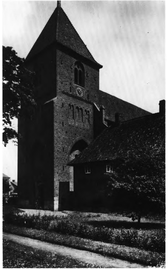
Fig. 40. Tårnet og klostrets vestfløj efter restaureringen 1918-32 (sml. fig. 39). V. Hermansen fot. 1946. — Turm und Westflügel des Klosters nach der Restauration von 1918-32.
