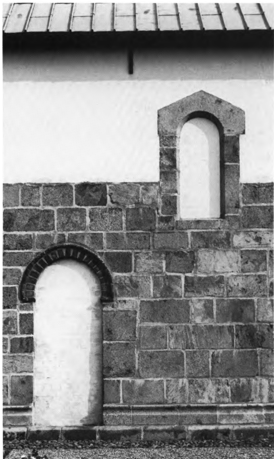
Fig. 10. Udsnit af skibets sydfacade med syddør (s. 1035) og romansk vindue (s. 1036). NE fot. 1982. — Südfassade des Schiffs, Ausschnitt mit Südportal und romanischem Fenster.
