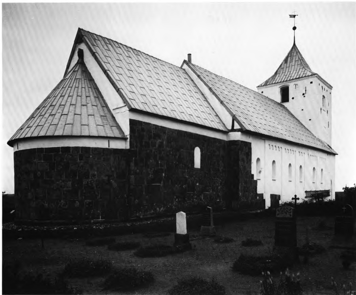
Fig. 8. Kirken set fra nordøst. Hude fot. 1905. — Die Kirche von Nordosten gesehen.
