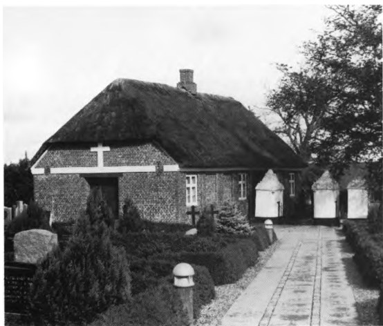
Fig. 7. Ligkapel, indrettet i tidligere skolebygning (s. 1137), samt kirkegårdens østre indgang. NJP fot. 1985. — Leichenhalle, eingerichtet im ehemaligen Schulgebäude, und östlicher Eingang zum Friedhof.
