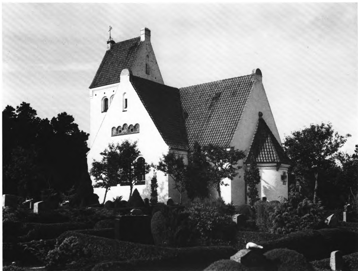
Fig. 1. Lønne nye kirke, opført 1904 af J. Magdahl Nielsen. Set fra sydøst. NE fot. 1980. — Neue Kirche von Lønne, erbaut 1904. Von Südosten gesehen.
