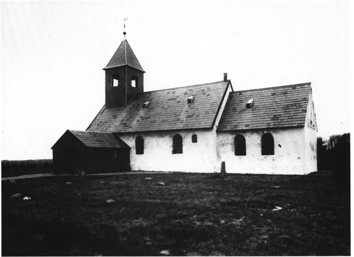
Fig. 9. Kirken set fra sydøst o. 1900, med skifertag og tagrytter fra 1879 samt støbejernsvinduer fra 1873. Fot. i Det kgl. Bibliotek. — Die Kirche von Südosten gesehen, um 1900, mit Schieferdach und Dachreiter von 1879 und gusseisernen Fenstern von 1873.
