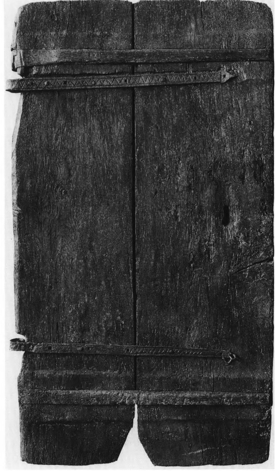
Fig. 29a-b. Dørfloj, middelalderlig, tilstand før restaurering 1952 (s. 1700). a. Forside med jernbeslag, b. Bagside. LL fot. 1949. – Türflügel, mittelalterlich, Zustand vor der Restaurierung 1952. a. Vorderseite mit Eisenbeschlage, b. Rückseite.
