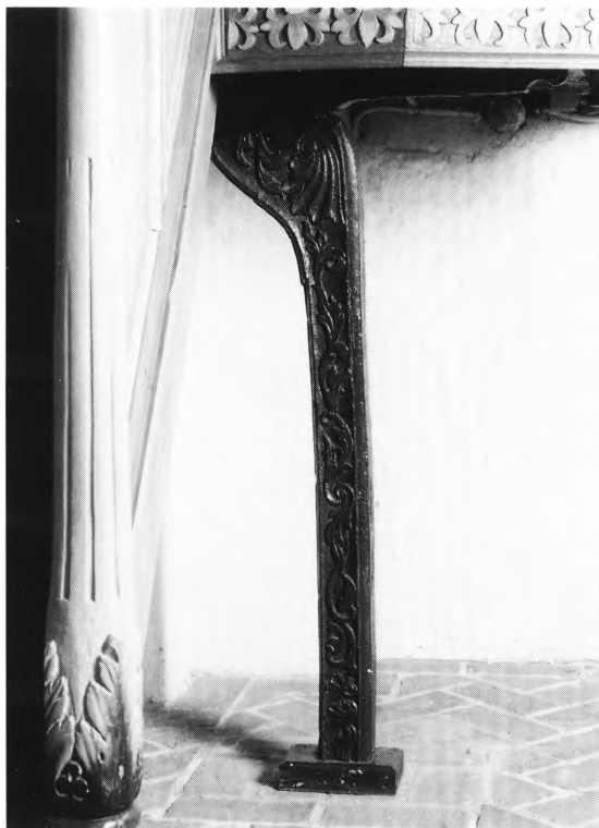
Fig. 36. Støtte under prædikestolen, et stykke genanvendt skibstømmer fra slutningen af 1600'erne (s. 1899). – Kanzelstütze aus wiederverwendetem Schiffbauholz. Ende des 17. Jahrhunderts.
