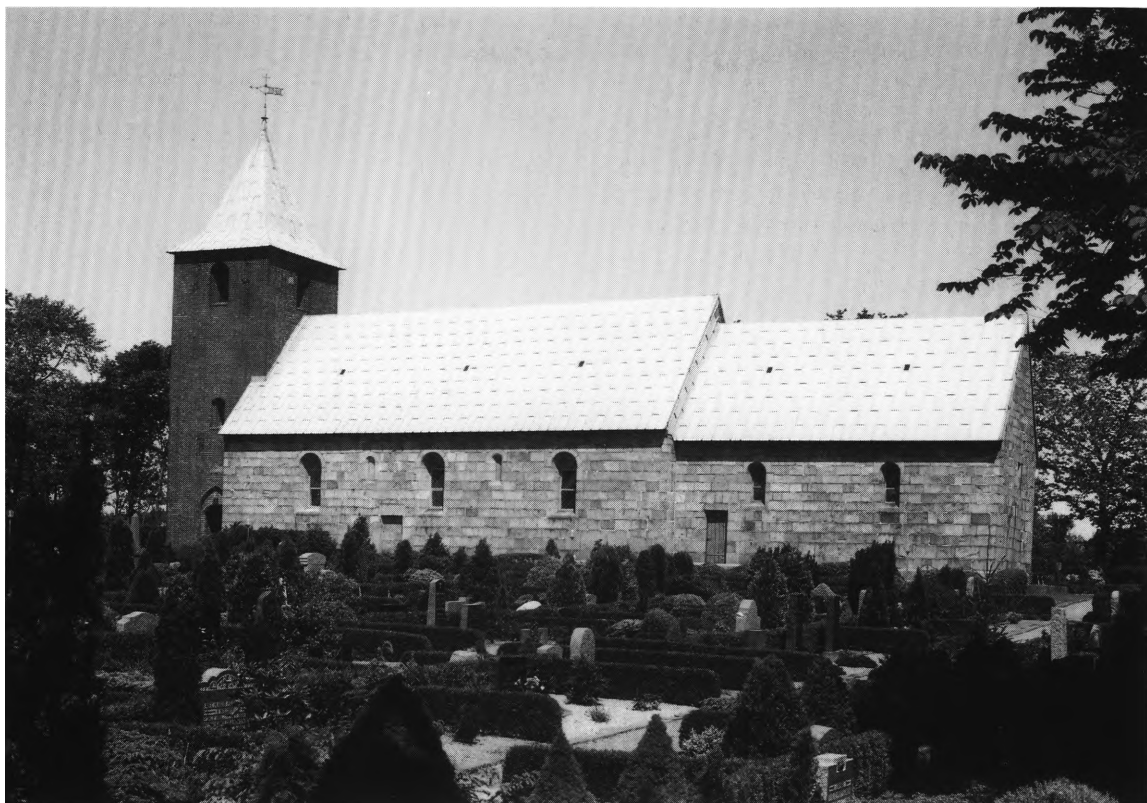
Fig. 1. Kirken set fra sydøst. NE fot. 1983. – Südostansicht der Kirche.
