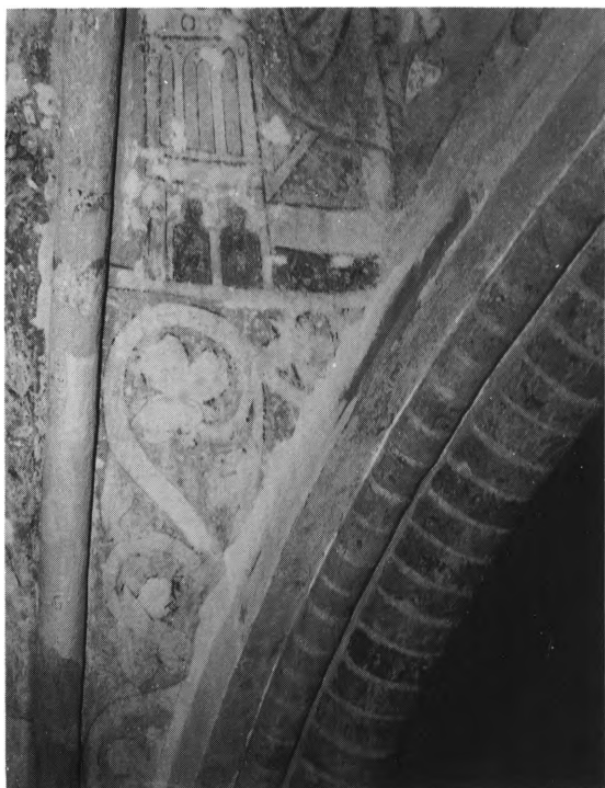
Fig. 37. Udsnit af korkhvælv med ribber og buer under istandsættelse samt kalkmalerier o. 1275 (s. 1938). Tage E. Christiansen fot. 1958. – Ausschnitt aus Chorgewölbe mit Rippen und Bogen bei der Restaurierung 1958. Gewölbemalereien um 1275.
