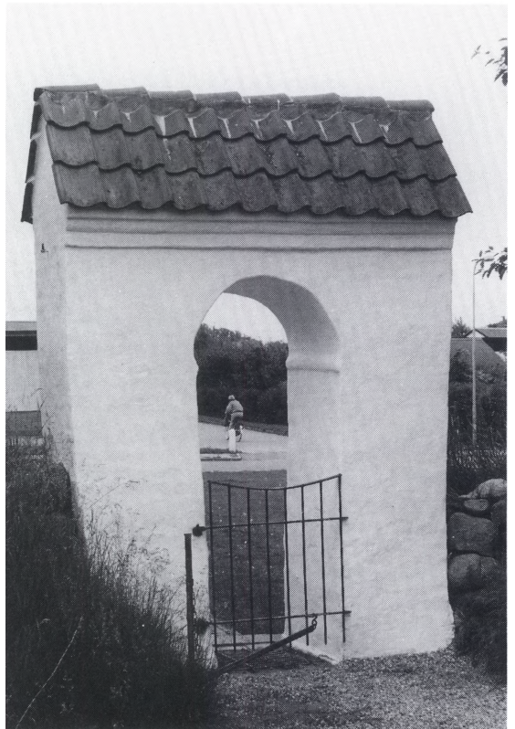
Fig. 3. Østre kirkegårdsportal set fra vest (s. 2056). NJP fot. 1990. - Östlicher Friedhofsportal von Westen .
