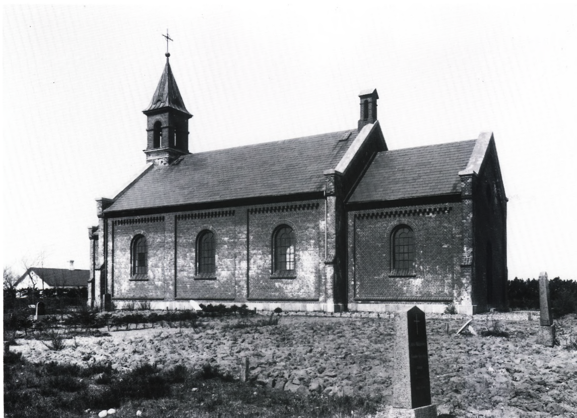
Fig. 1. Kirken set fra sydøst o. 1910, mens gavlene endnu stod med murede kamme. Foto i Det kgl. Bibliotek. – Südostransicht der Kirche mit den noch damals bestehenden Stufengiebeln. Um 1910.
