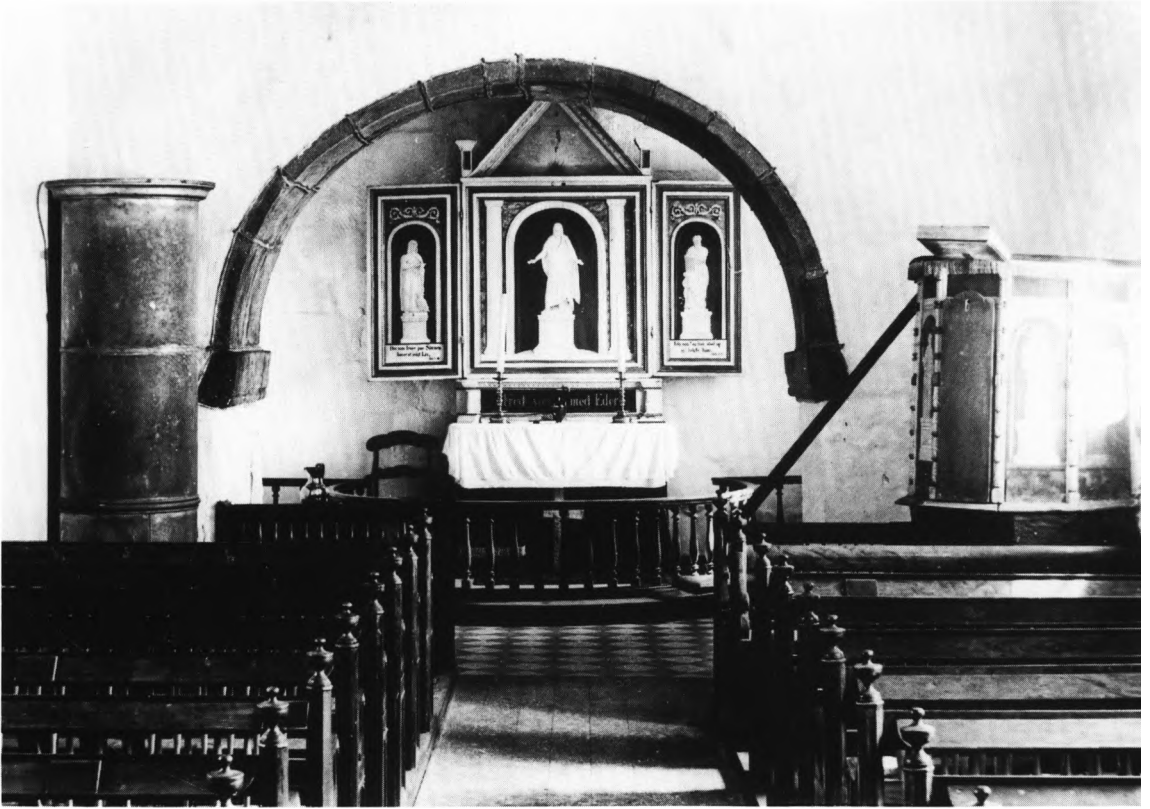
Fig. 4. Indre set mod øst kort før nedrivningen 1896. Foto i Vejen lokalhistoriske arkiv. – Innenansicht gegen Osten kurz vor dem Abreissen 1896.
