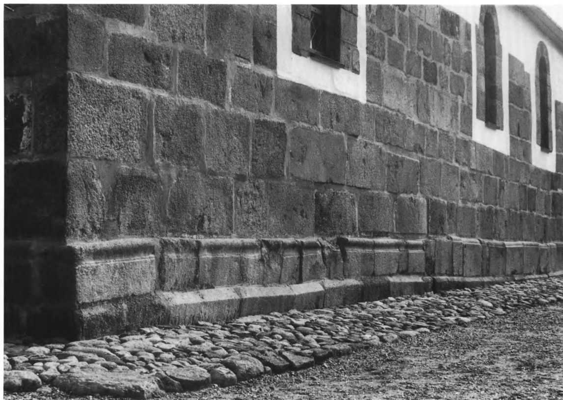
Fig. 8. Skibets vestre del med profileret sokkel (s. 2390) og genanvendte apsiskvadre (s. 2393). NJP fot. 1991. – Westlicher Schiffsteil mit profiliertem Sockel und wiederverwendeten Quadern von der Apsis.
