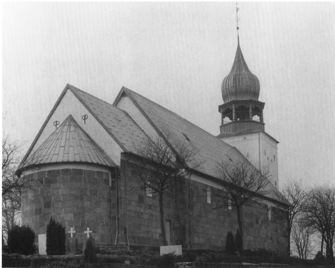
Fig. 7. Kirken set fra nordøst. NJP fot. 1992. – Nordostansicht der Kirche.
