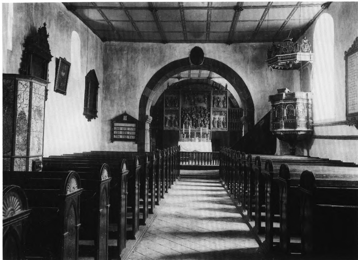
Fig. 30. Indre set mod øst. Hude fot. o. 1910. – Innenansicht nach Osten um 1910.
