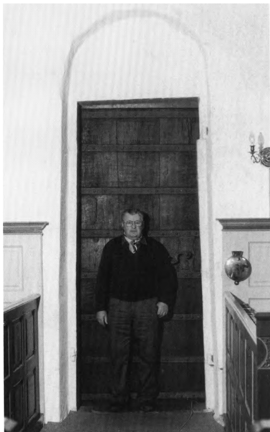
Fig. 66. Skibets sydportal, set indefra (s. 2473). NJP fot. 1992. – Blick von Innen auf das Säulenportal in Schiffssüdwand.
