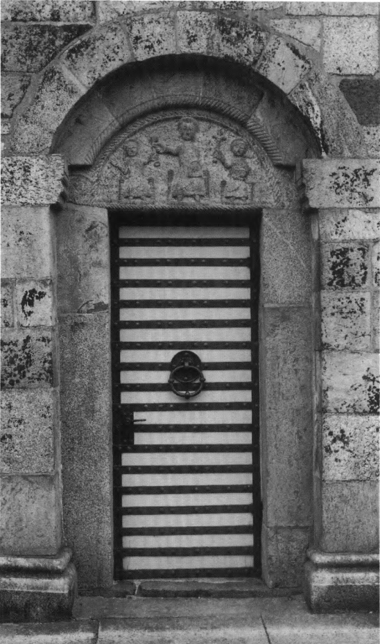
Fig. 9. Norddør set udefra (s. 2546). NE fot. 1985. – Norderportal
