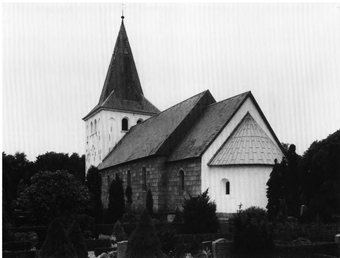
Fig. 6. Kirken set fra sydøst. NE fot. 1985. – Südostansicht der Kirche.
