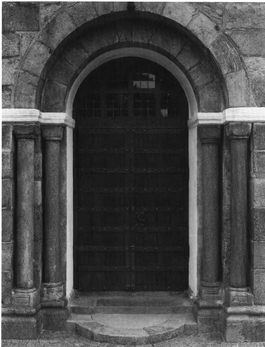
Fig. 12. Den gamle sydportal, i portalfremspring i tårnets vestside. Portalen er flyttet til tårnet 1862 (s. 2548). NE fot. 1985. – Das altes Süderportal im Portalvorsprung in westlicher Turmwand. Das Portal ist 1862 wurde den Turm eingebaut.
