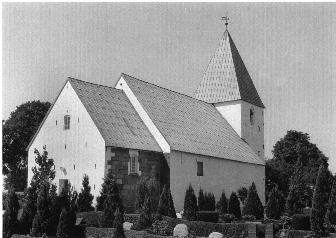
Fig. 7. Kirken set fra nordøst. NJP fot. 1992. – Nordostansicht der Kirche.
