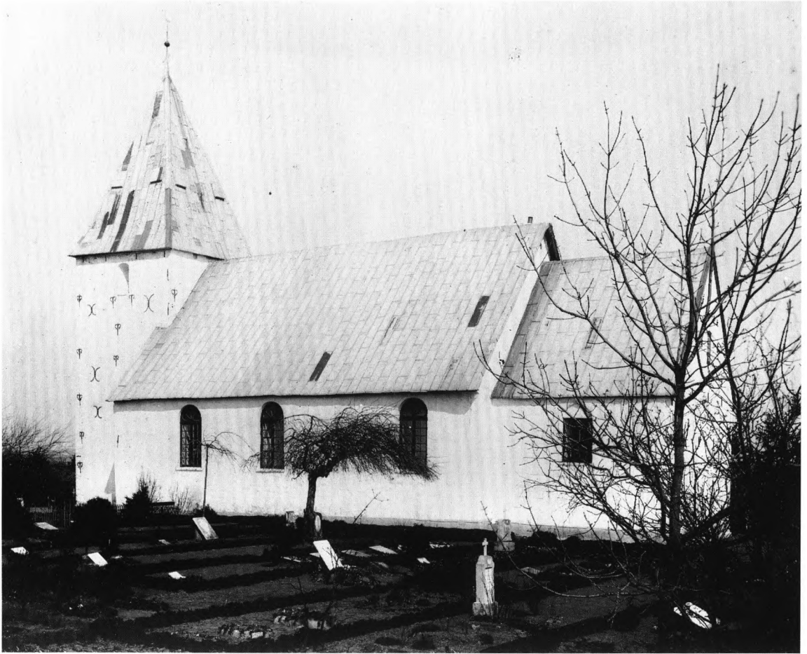
Fig. 35. Kirken set fra sydøst. Foto o. 1900. – Südostansicht der Kirche.
