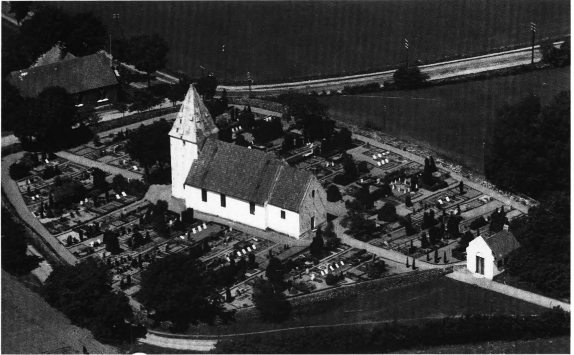
Fig.3. Luftfoto af kirken og kirkegården set fra sydøst. Sylvest Jensen fot. 1947. Det kgl. Bibliotek. – Luftaufnahme von Kirche und Friedhof Südostansicht.
