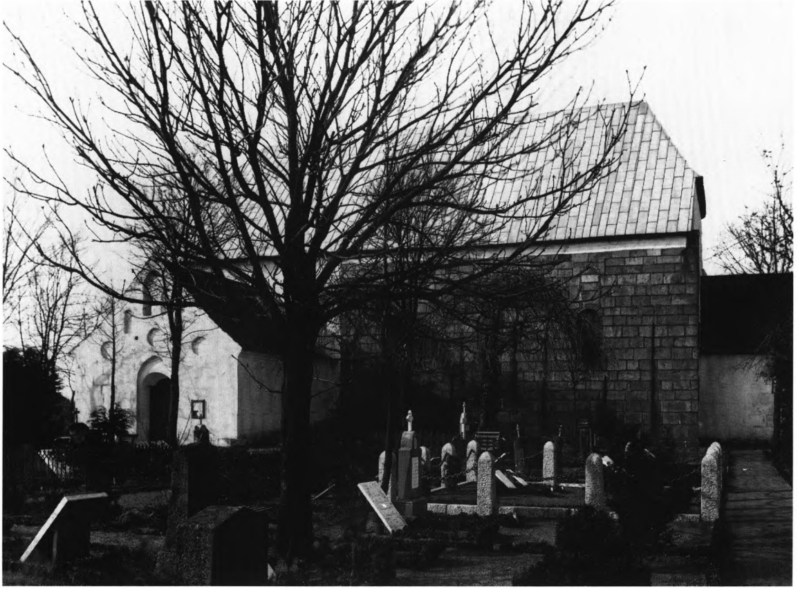
Fig. 28. Kirken set fra syd kort før ombygningen 1919. Fot. i NM. – Südsicht der Kirche kurz vor dem Umbau.
