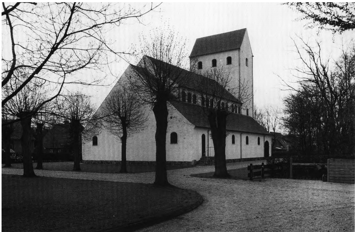
Fig. 3. Kirken set fra nordøst. NE fot. 1988. – Nordostansicht der Kirche.
