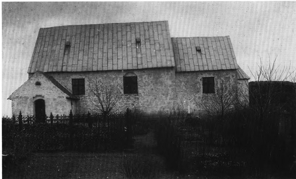
Fig. 9. †Kirken set fra syd kort før nedrivningen. L. Poulsen fot. Ved embedet. – Südansicht der †Kirche kurz vor dem Abbruch.
