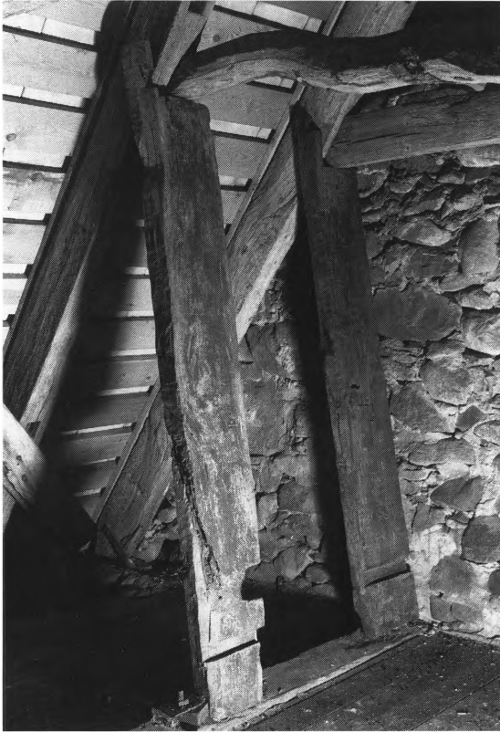
Fig. 6. Parti af korets tagrum (s. 2916) med planker fra (†)dørfløj o. 1650 (s. 2931), genanvendt som skråstivere. EN fot. 1993. - Chor, Dachboden. Partie mit den als Streben wiederverwendeten Planken eines (†)Türflügels, um 1650.
