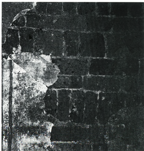
Fig. 12. Udsnit af tufstensmurværk i skibets sydvæg (s. 3028). J. J. Dalgaard fot. 1979. – Ausschnitt aus Tuff-mauerwerk in südlicher Schiffsinnenwand.
