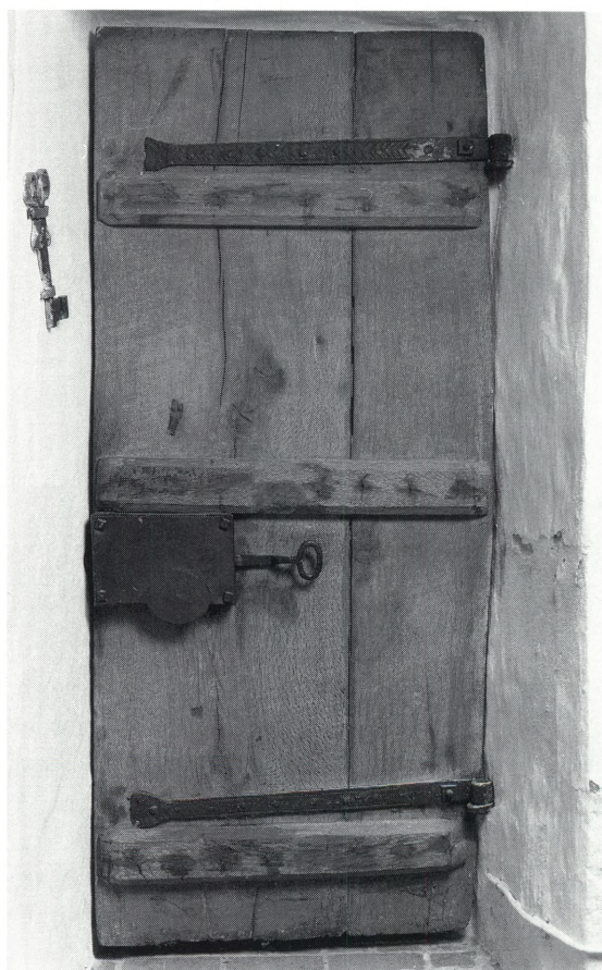
Fig. 19. Dørfloj fra 1700'erne mellem skib og våbenhus (s. 3184). NE fot. 1989. – Türflügel, 18. Jh., zwischen Schiff und Vorhaus.
