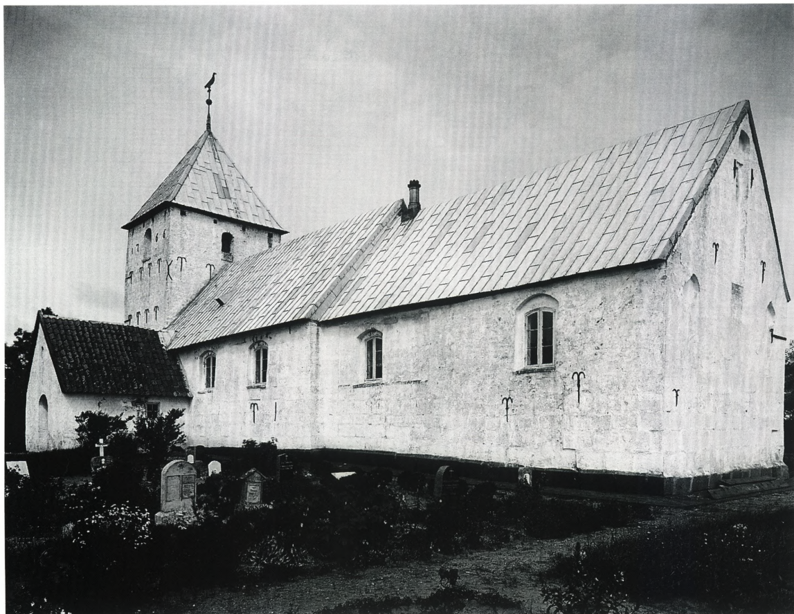
Fig. 7. Kirken set fra sydøst. Kr. Hude fot. 1905. – Südostansicht der Kirche.
