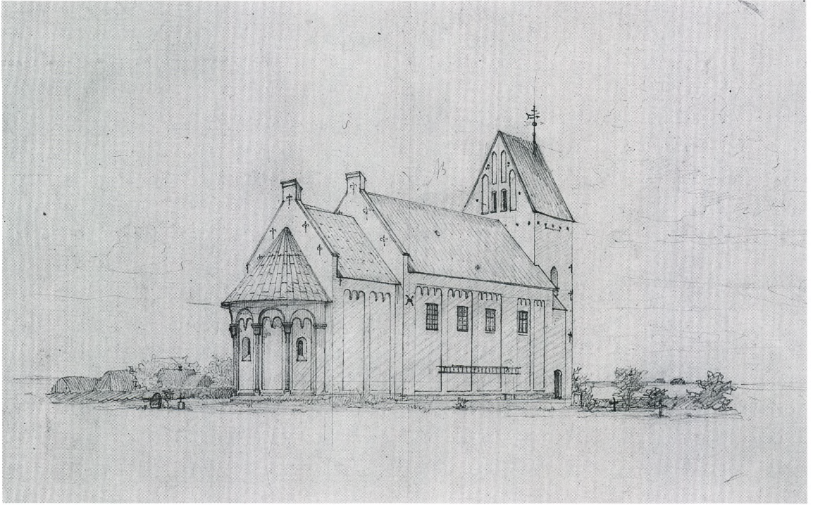
Fig. 17. Kirken set fra nordøst. Forarbejde til Danske Tufstenskirker. Blyantstegning ved Erik Schiødt 1884. – Nordostansicht der Kirche. Zeichnung, Bleistift, 1884.
