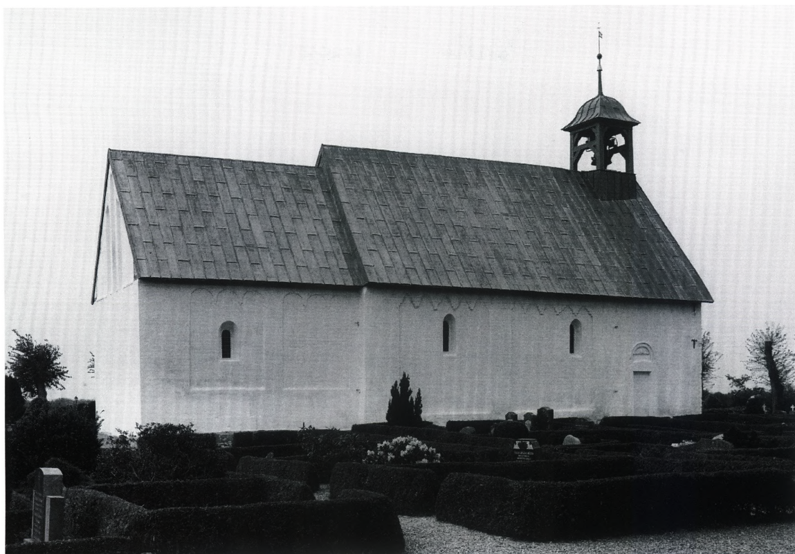
Fig. 8. Kirken set fra nordøst. NE fot. 1995. – Nordostansicht der Kirche.
