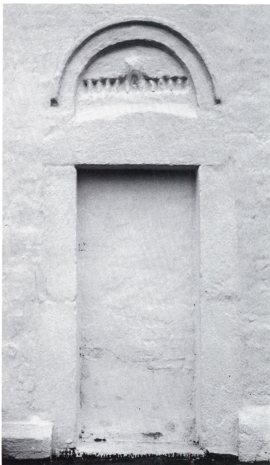
Fig. 6. Skibets nordportal (s. 3350). NE fot. 1995. – Nordportal des Kirchenschiffs.
