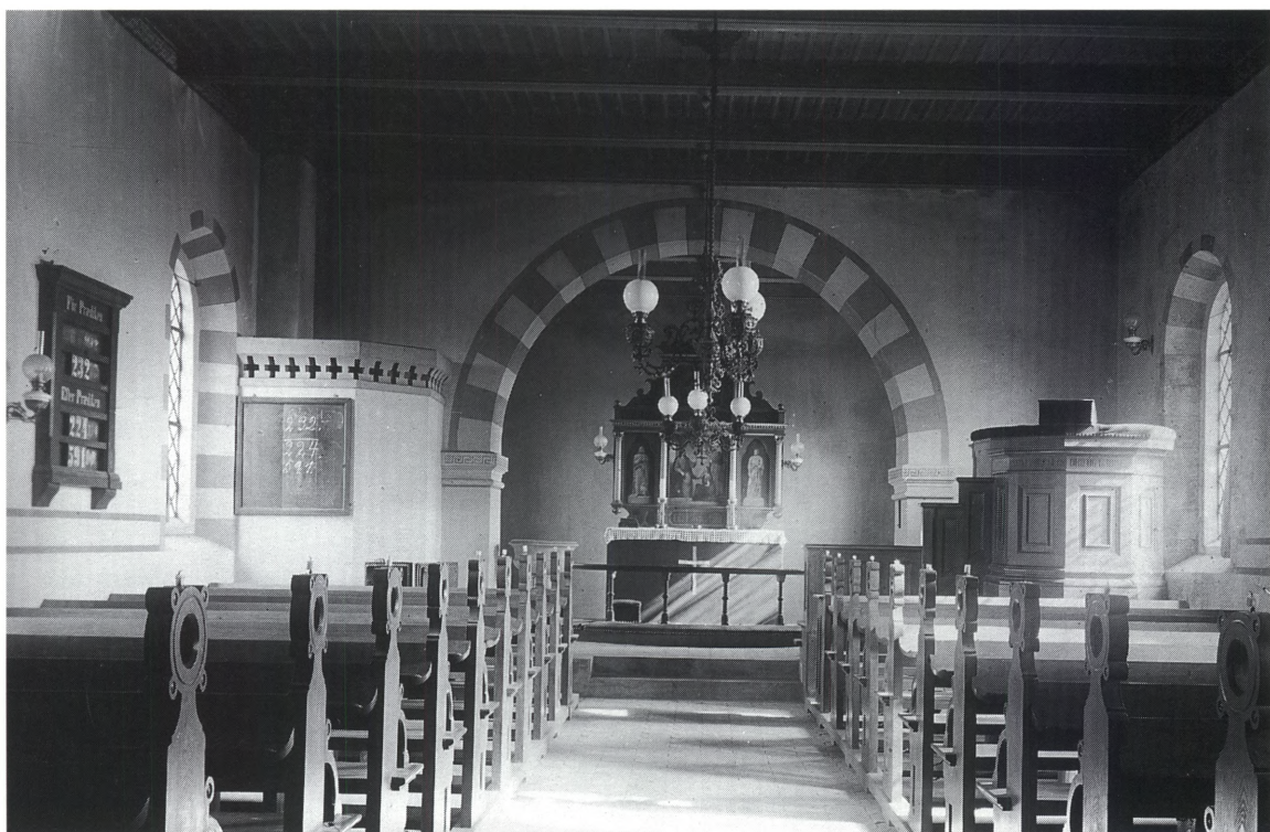
Fig. 5. Indre set mod øst. Fotografi i NM2. – Kircheninneres gegen Osten vor der Restaurierung in den 1980er Jahre.
