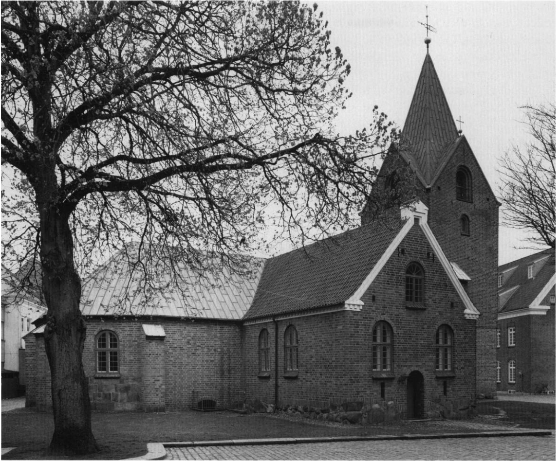
Fig. 6. Kirken set fra nordøst. HW fot. 1997. - Nordostansicht der Kirche.
