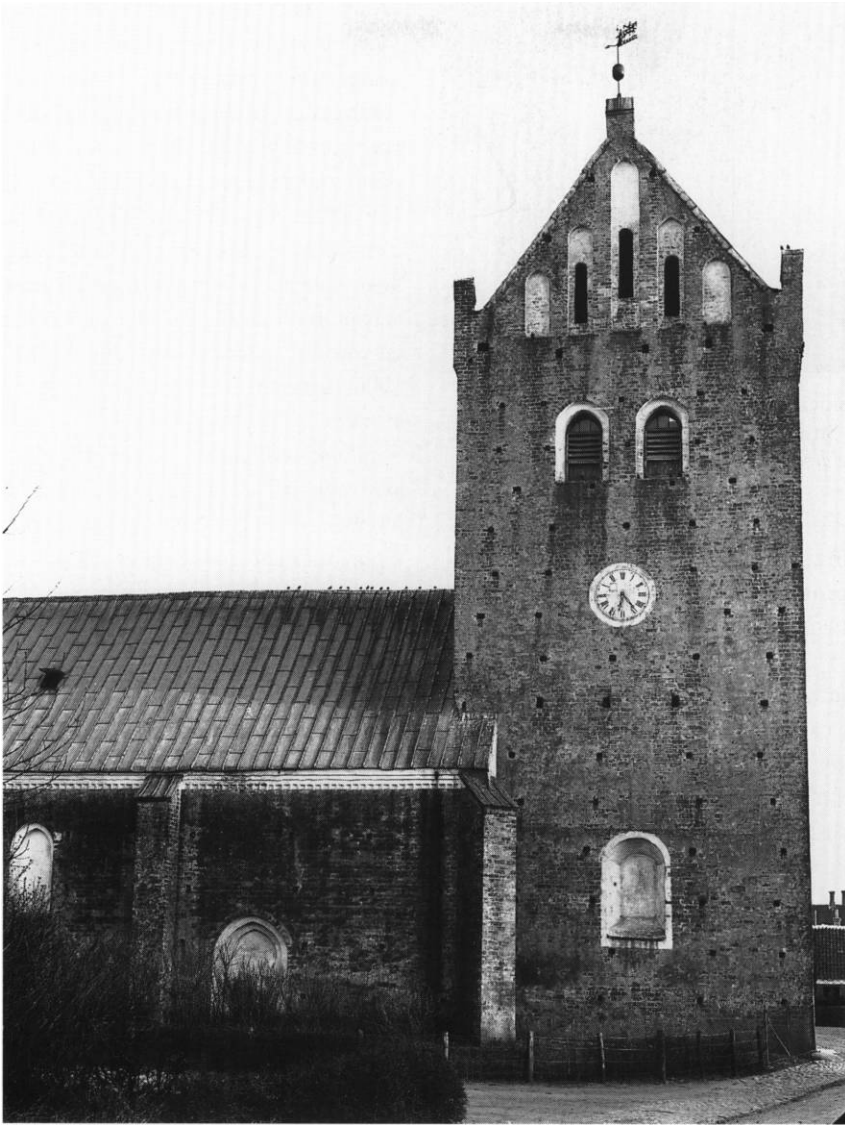
Fig. 36. Tårnet set fra nord (s. 195). A. Vorbeck fot. 1904-05. - Turm, Nordansicht 1904-05.
