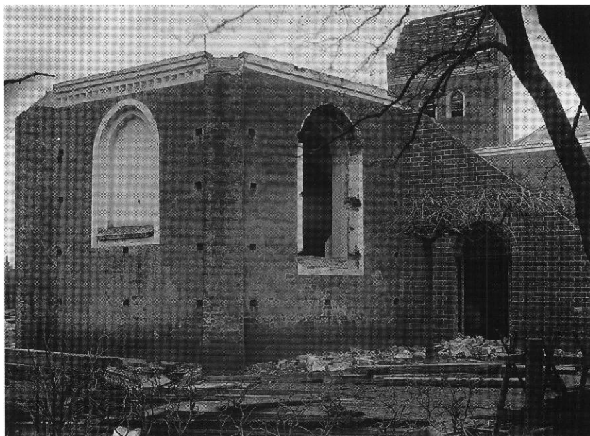
Fig. 17. Kirken under nedrivning. Kor og sakristi set fra nordøst. C. M. Smidt fot. 1906. - Die Kirche während des Abbruchs. Chor und Sakristei, Nordostansicht, 1906.
