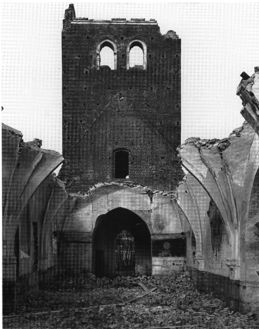
Fig. 34. Kirkens indre set mod vest efter hvælvenes nedrivning. A. Vorbeck fot. 1906. - Kircheninneres gegen Westen nach Abbruch der Gewölbe. Zustand 1906.
