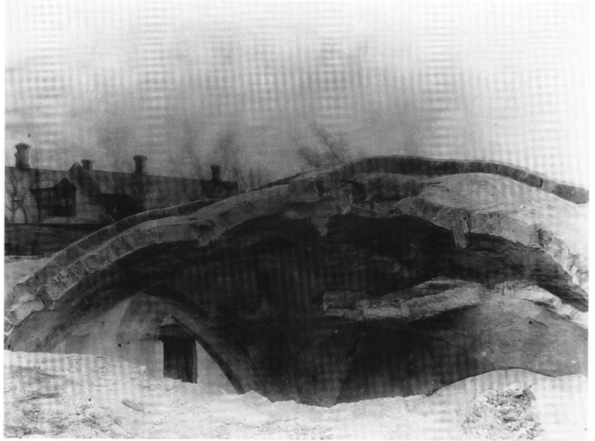
Fig. 149. Hvælvet i langhusets 2. fag under nedrivning, fotograferet i det øjeblik nordøstre kappe styrter sammen. I kappen ses et hul med jernforstærkning (s. 190); set mod sydvest. C. M. Smidt fot. 1906. - Ge-wölbe des 2. Langhaus-jochs während des Ab-bruchs. Bildaufnahme im selben Moment, wo die nordöstliche Kappe ein-bricht. In der Kappe eine Öffnung mit eisener Ver-stärkung, 1906.
