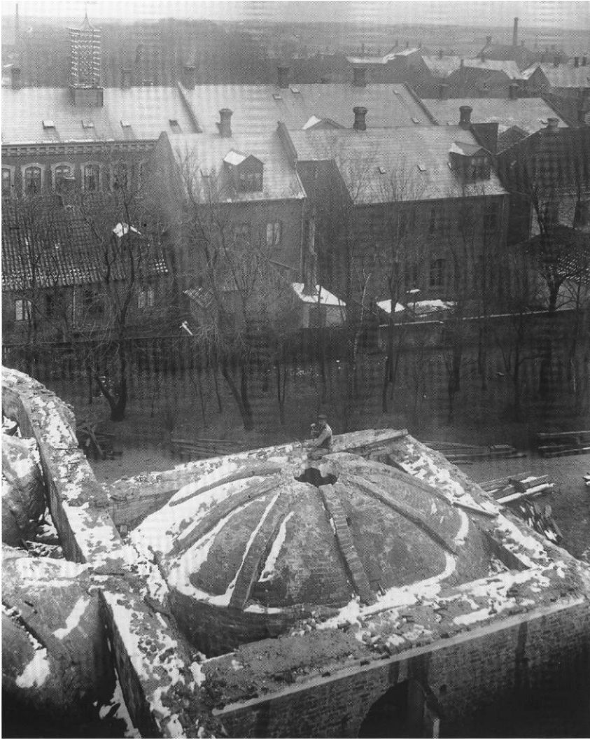
Fig. 44. Søndre kapels hvælv under nedrivning (s. 195), set mod sydøst fra tårnets top. C. M. Smidt 1906. - Gewölbe des südlichen Kapellenanbaus während des Abbruchs. Aufnahme von der Turmspitze in Richtung Südosten, 1906.
