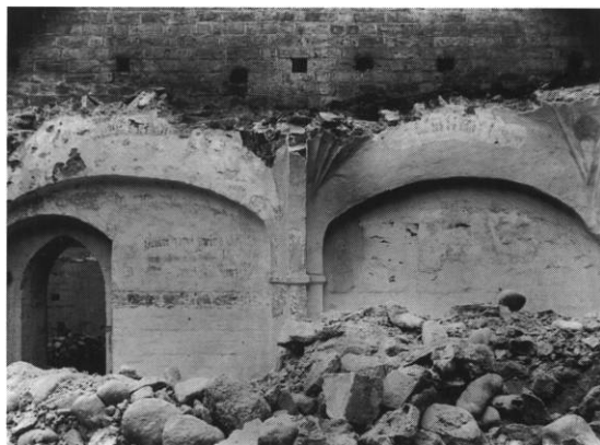
Fig. 29. Sakristiets sydvæg efter hvælvenes nedrivning (s. 190); længst mod øst døren til koret (s. 183). C. M. Smidt fot. 1906. - Südwand der Sakristei nach Abbruch der Gewölbe; am weitesten nach Osten die Tür zum Chor, 1906.
