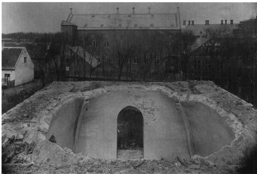
Fig. 42. Nordre kapel under nedrivning, set mod nord. C. M. Smidt fot. 1906. - Nördlicher Kapellenanbau gegen Norden während des Abbruchs, 1906.
