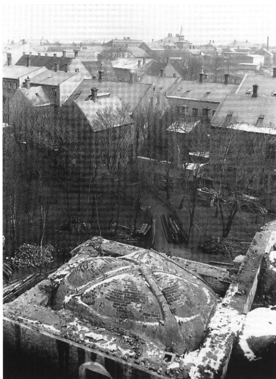
Fig. 40. Oversiden af nordre kapels hvælv (s. 202), set mod nordøst fra tårnets top. C. M. Smidt fot. 1906. - Oberseite des Gewölbes, nördlicher Kapellenanbau. Bildaufnahme von der Turmspitze gegen Nordosten, 1906.
