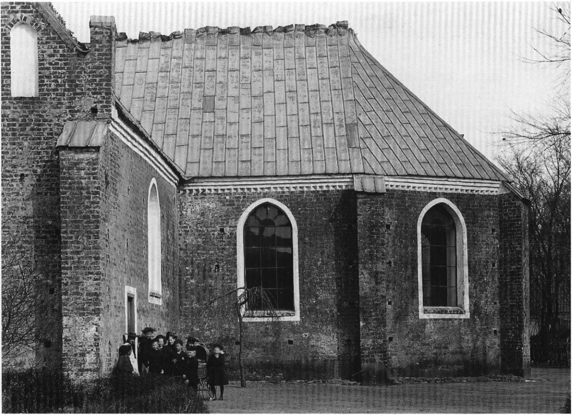
Fig. 18. Koret set fra syd. A. Vorbeck fot. 1906. - Südsicht des Chors, 1906.
