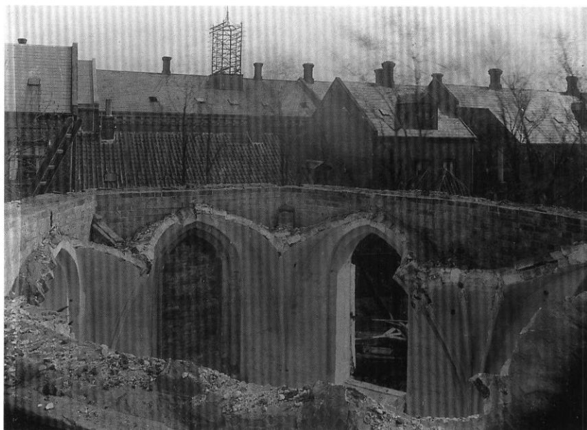
Fig. 25. Korpolygonen efter hvælvets nedrivning, set mod øst. C. M. Smidt fot. 1906. - Der dreiseitige Chorschluß nach Abbruch des Gewölbes. Bildaufnahme gegen Osten, 1906.
