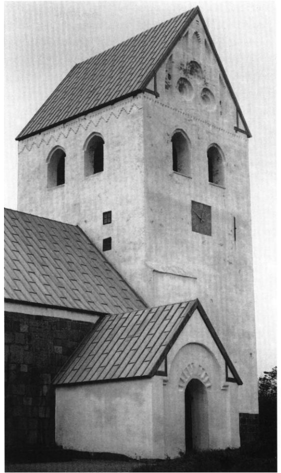
Fig. 10. Tårn og våbenhus set fra nordøst. NJP fot. 2000. - Turm und Vorhaus, Nordostansicht.
