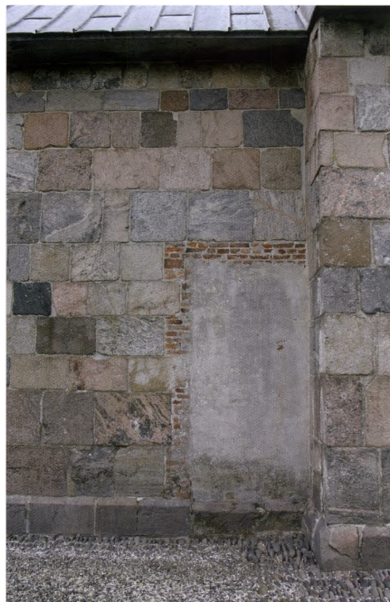
Fig. 57. Udsnit af korets nordside med blændet dør til \dagger herskabspulpitur (s. 828). Foto Hugo Johannsen 2007. — Ausschnitt von der Nordseite des Chores mit verblendeter Tür zur \dagger Herrschafts empore.
