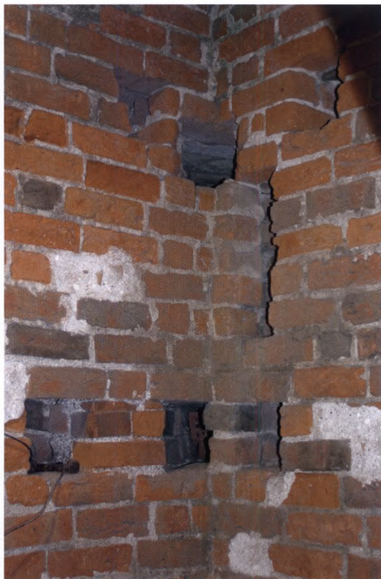
Fig. 18. Detalje af murværk i klokkestokværkets nordøstre hjørne med stilladshuller (s. 825). Foto Hugo Johannsen 2007.- Detail des Mauerwerks mit Gerüstlöchern in der nordöstlichen Ecke des Glockenstockwerkes.
