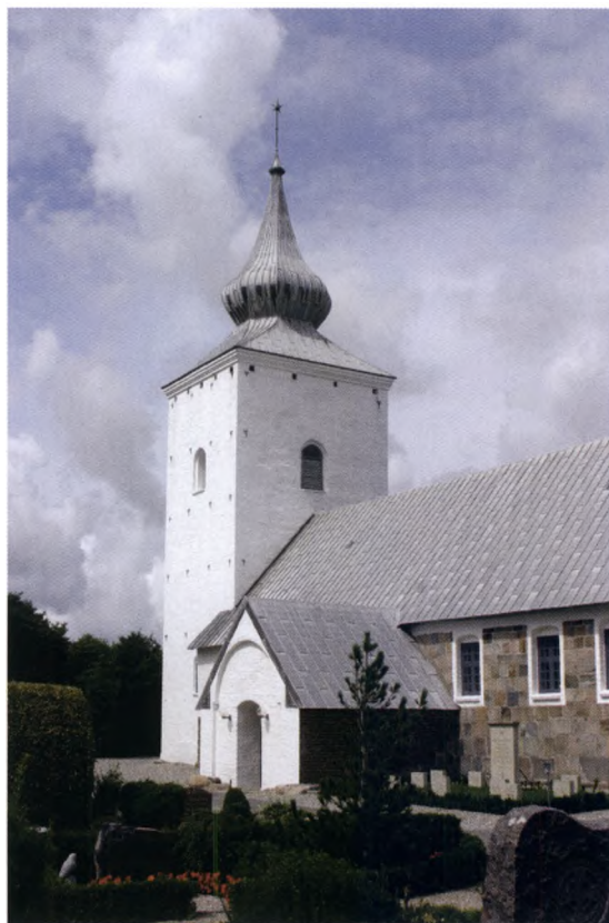
Fig. 17. Våbenhus (s. 826) og tårn (s. 825), set fra sydøst. Foto Hugo Johannsen 2007. — Waffenhaus und Turm, Südostansicht.
