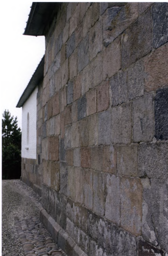
Fig. 7. Udsnit af skibets nordside, set mod østhjørnet og let fremspringende murværk indtil byggestop (s. 819). Foto Hugo Johannsen 2007. — Ausschnitt von der Nordseite des Schiffes, gegen die Ostecke und leicht vorspringendes Mauerwerk bis zum Baustop.
