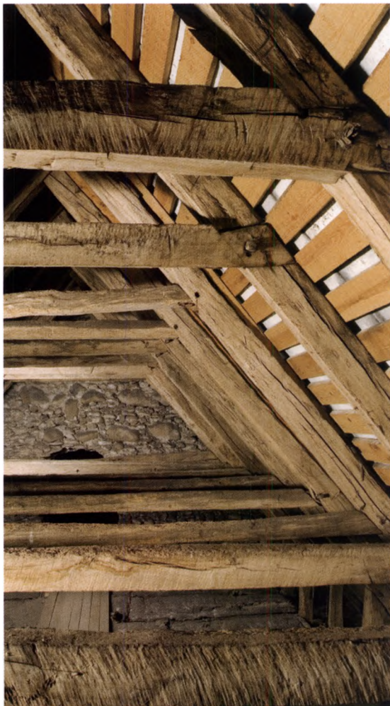
Fig. 20. Detalje af korets tagværker (s. 829), set mod skibets taggavl (s. 819). Foto Arnold Mikkelsen 2007. — Detail von den Dachstühlen des Chores, gegen den Dachgiebel des Schiffes.
