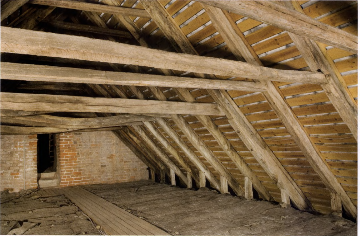
Fig. 21. Detalje af skibets tagværker (s. 829), set mod døren til tårnet (s. 826). Foto Arnold Mikkelsen 2007. - Detail von den Dachstühlen des Schiffes, gegen die Tür zum Turm.
