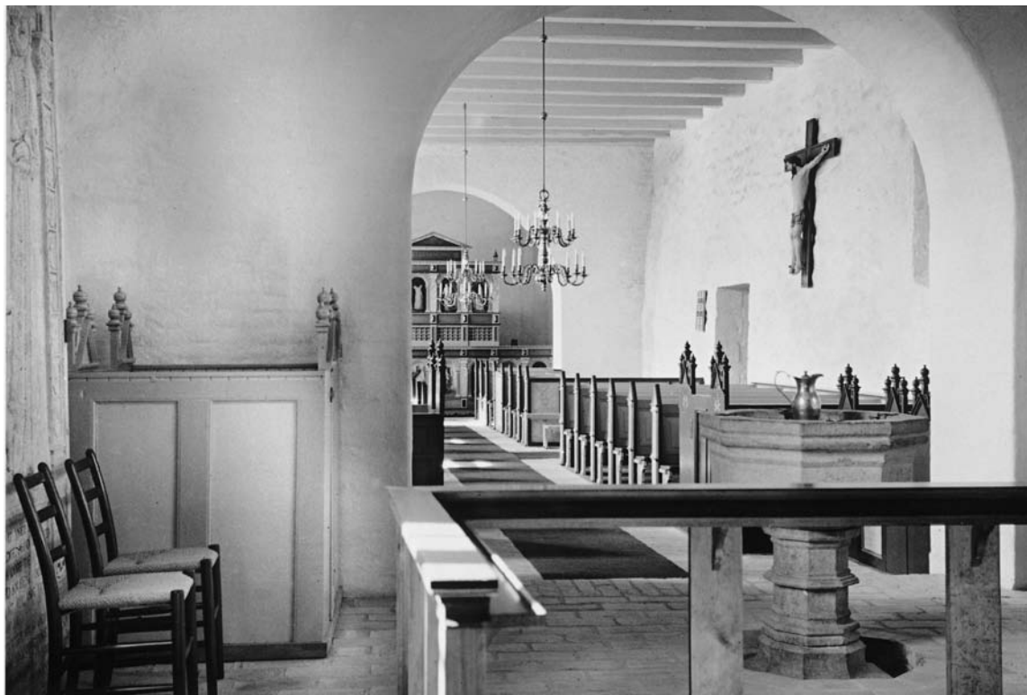
Fig. 38. Interiør af koret, set mod sydvest, med herskabsstol fra 1600-tallets første halvdel (s. 911). Foto Sv. Fritz før 1945 i Orgelregistranten. – Chorinneres, gegen Südwesten, mit Herrschaftsstuhl aus der ersten Hälfte des 17. Jahrhunderts.
