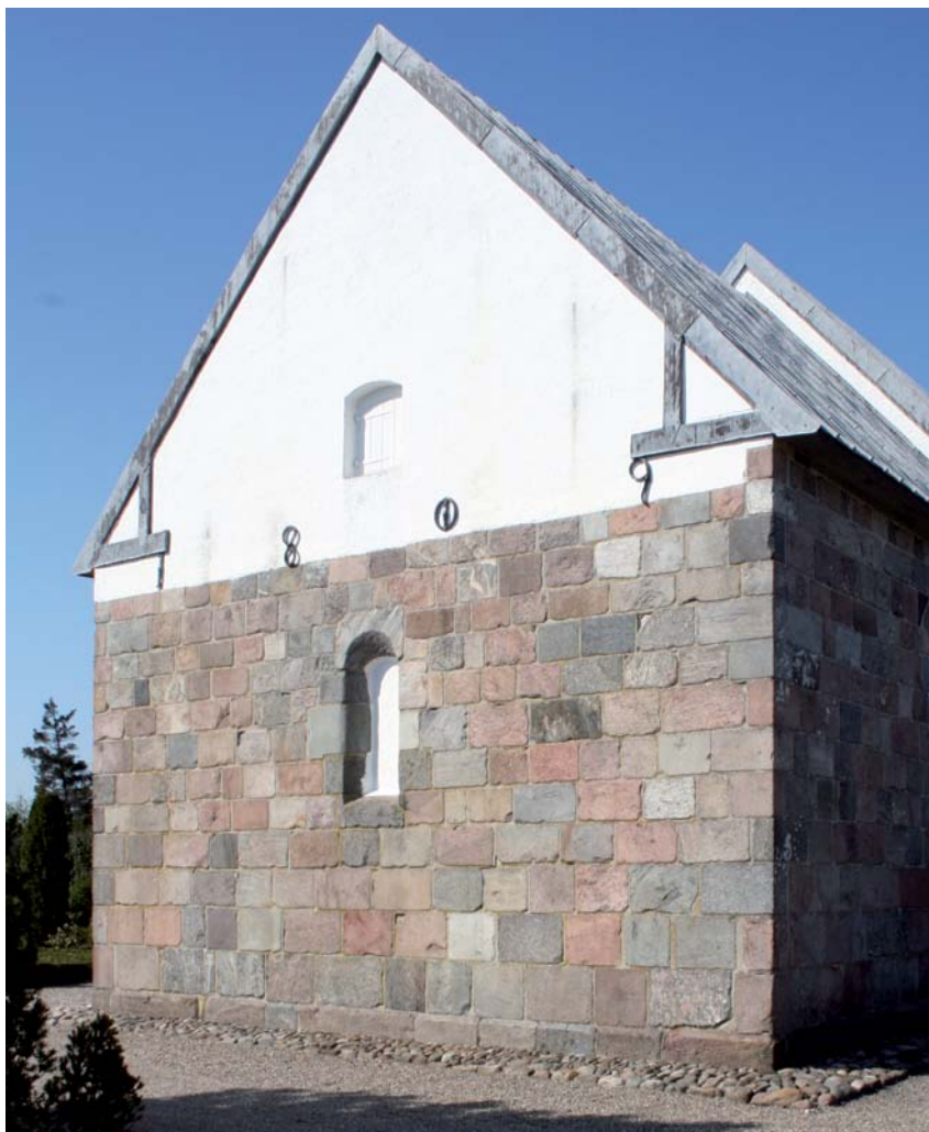
Fig. 3. Koret set fra nordøst. Foto Mogens Vedsø 2009. – Chorwand, Nordostansicht.
