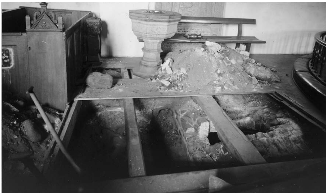
Fig. 53. Opgravning af korgulvet i forbindelse med hovedrestaurationen, med frilægning af korbuens sokkelsten og tømuret begravelse (s. 888, 922). Foto M. B. Fritz & Søn 1937. – Ausgrabung des Chorbodens in Verbindung mit der Hauptrestauration, mit Freilegung von Sockelstein des Chorbogens und des tømureten Begräbnisses.
