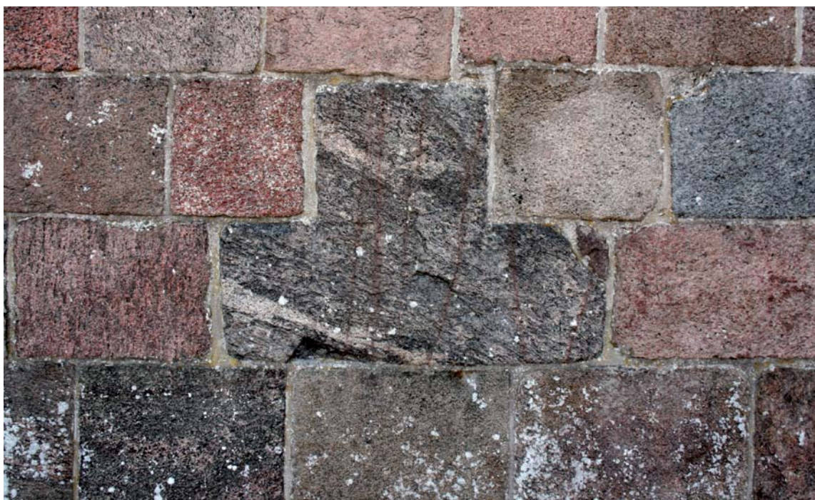
Fig. 7. Udsnit af kvadermurværk i skibets nordside med en falset kvader (s. 884). Foto Mogens Vedsø 2009. – Ausschnitt aus Quadermauerwerk in der Nordseite des Schiffes, ein Quader mit Falz.
