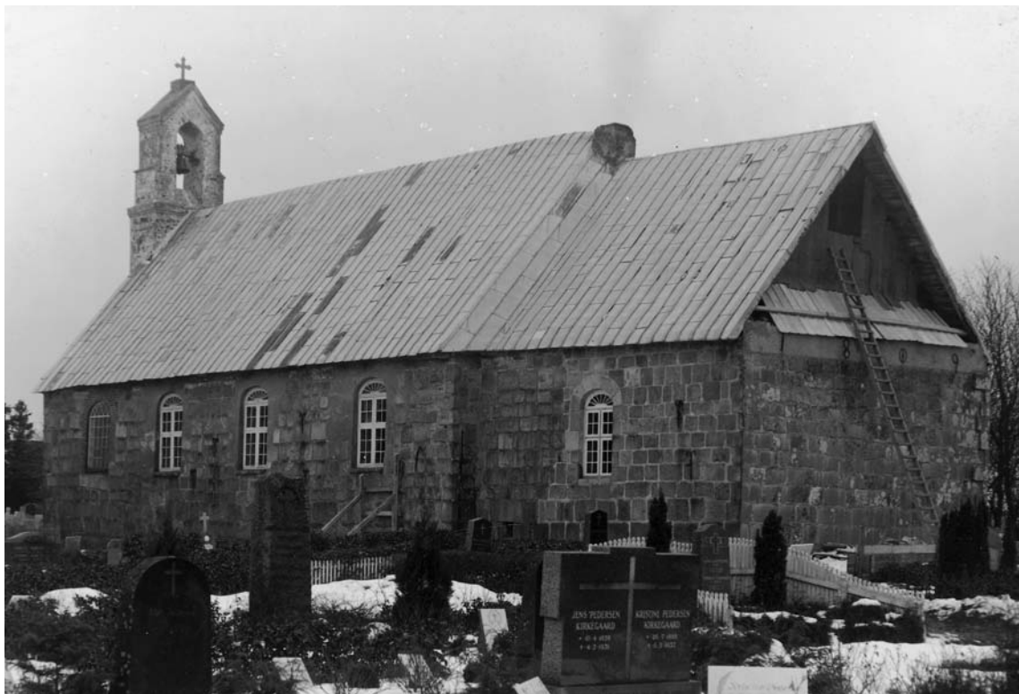
Fig. 15. Kirken under restaurering 1940, set fra sydøst. Foto M. B. Fritz & Søn 1940. – Die Kirche während der Restaurierung 1940, Südostansicht.
