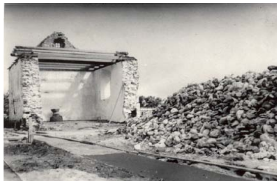
Fig. 37. Kirken under ombygning 1938. Foto i Nees Lokalkiv. – Kirche während des Umbaus 1938.
