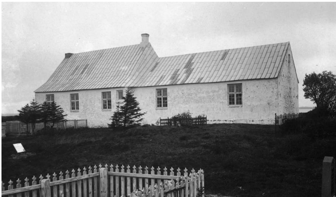
Fig. 9. Kirken set fra sydøst. Foto (o. 1910). – Südostansicht der Kirche.
