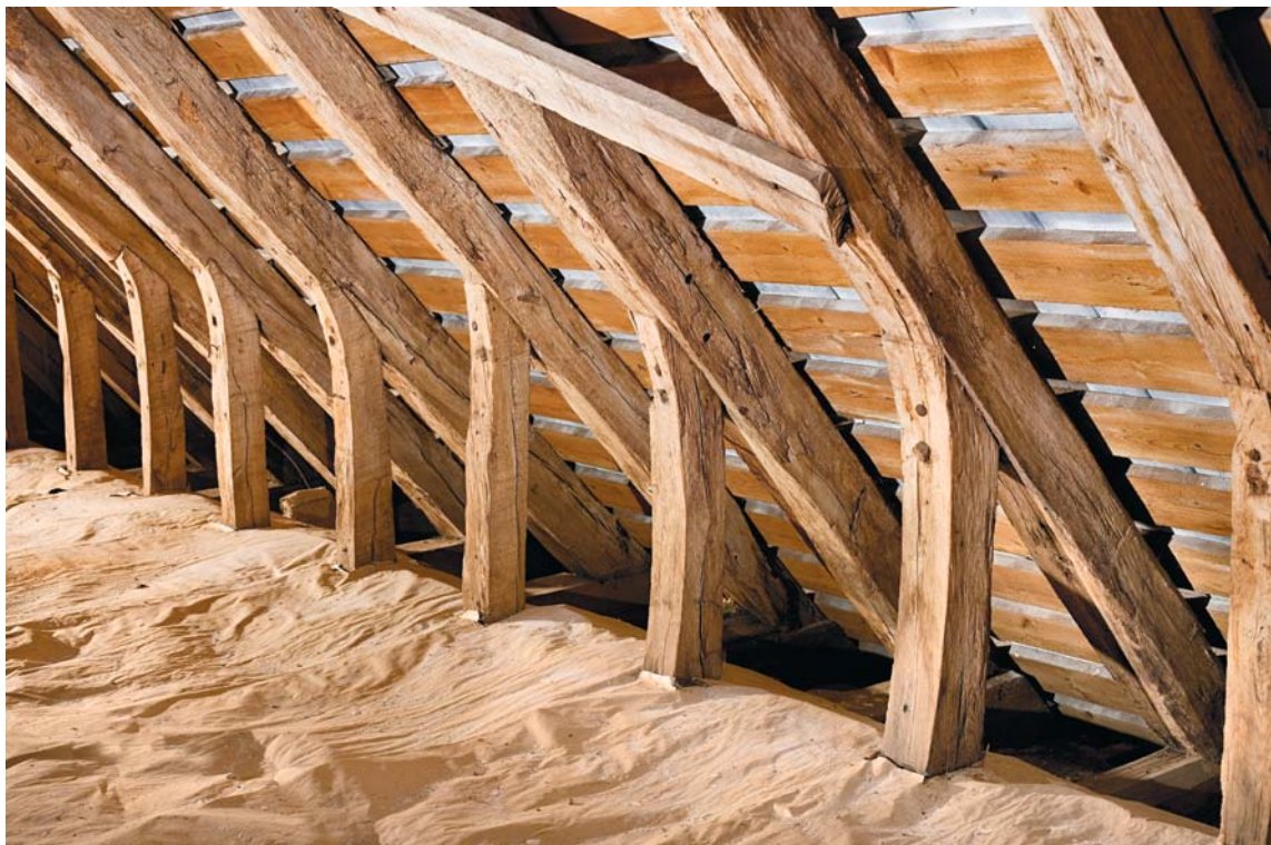
Fig. 19. Detalje af skibets tagværk med spærstivere i nordsiden (s.1103). Foto Arnold Mikkelsen 2009. – Detail vom Dachstuhl des Schiffes mit Stuhlsäulen in der Nordseite.
