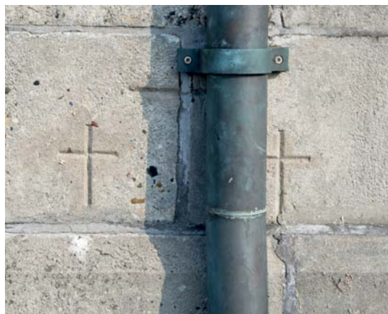
Fig. 70. Markering af grundstensens plads i korets sydøstre hjørne (s. 1259). Foto Hugo Johannsen 2010. – Markierung des Grundsteins in der südöstlichen Ecke des Chores.
