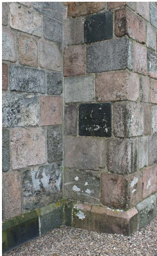
Fig. 11. Udsnit af kirkens nordside med sammenstød mellem korets og skibets sokler (s. 1335). Foto Hugo Johannsen 2010. – Ausschnitt von der Nordseite der Kirche mit Zusammenstoss zwischen Sockeln des Chores und Schiffes.
