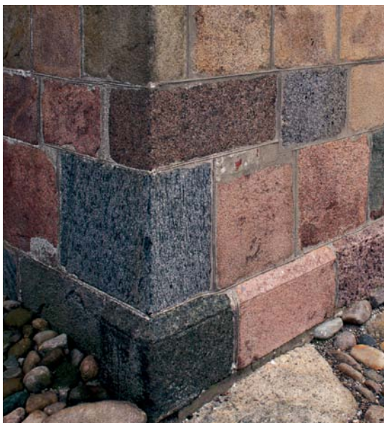
Fig. 9. Detalje af korsarmens sokkel set fra sydvest (s. 1375). Foto Hugo Johannsen 2010. – Detail vom Sockel des Kreuzarms, Südwestansicht.
