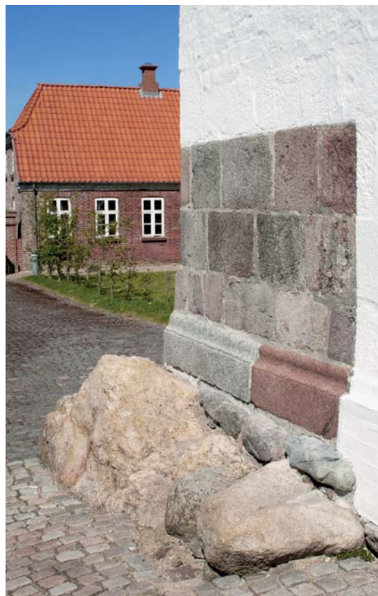
Fig. 14. Detalje af tårnets vestside med udflyttet sokkel over syldsten (s. 1457). Foto Hugo Johannsen 2011. – Detail der Westseite des Turmes mit versetztem Sockel aus Granitquadern.
