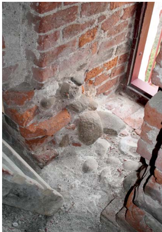
Fig. 35. Detalje af tårnets overdør, set fra mellemstokværket (s. 1458). Foto Hugo Johannsen 2010. – Detail von der Obertür des Turmes, vom Zwischenstockwerk aus gesehen.
