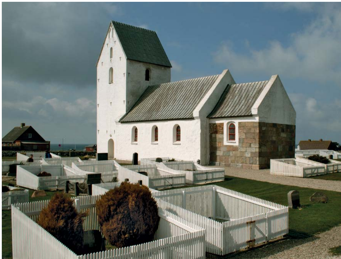
Fig. 7. Ydre set fra sydøst. Foto Hugo Johannsen 2010. – Äußeres aus Südosten.
