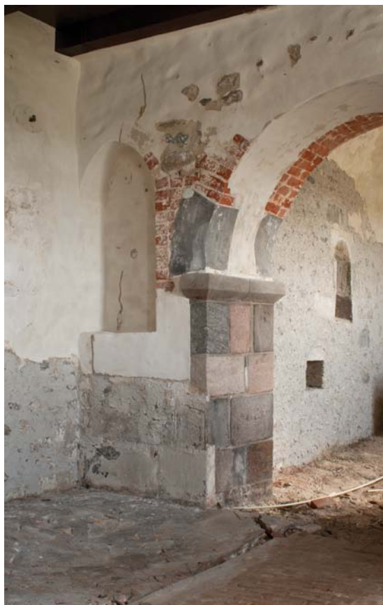
Fig. 12. Detalje af korbuen og triumfvæggens nordre halvdel set fra vest under kirkens restaurering 2011-12 (s. 1487, 1489). Foto Hugo Johannsen 2011. – Detail der nördlichen Hälfte von Chorbogen und Triumphwand während der Restaurierung der Kirche 2011-12.
