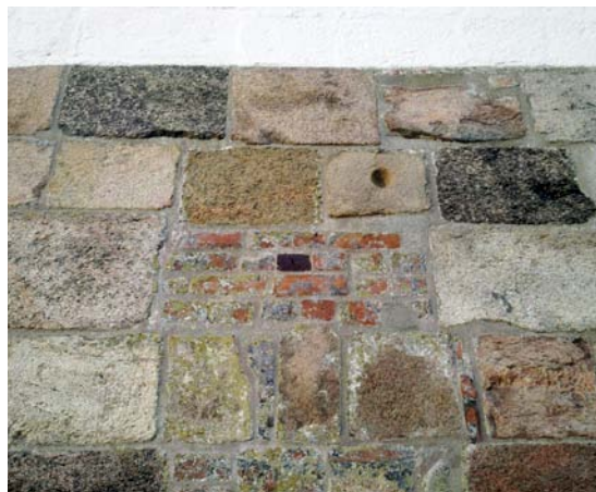
Fig. 57. Granitkvader med cirkulær fordybning over korets blændede østvindue (s. 1484). Foto Henriette Rensbro 2011. – Granitquader mit kreisförmiger Vertiefung über verblendetem Ostfenster des Chores .
