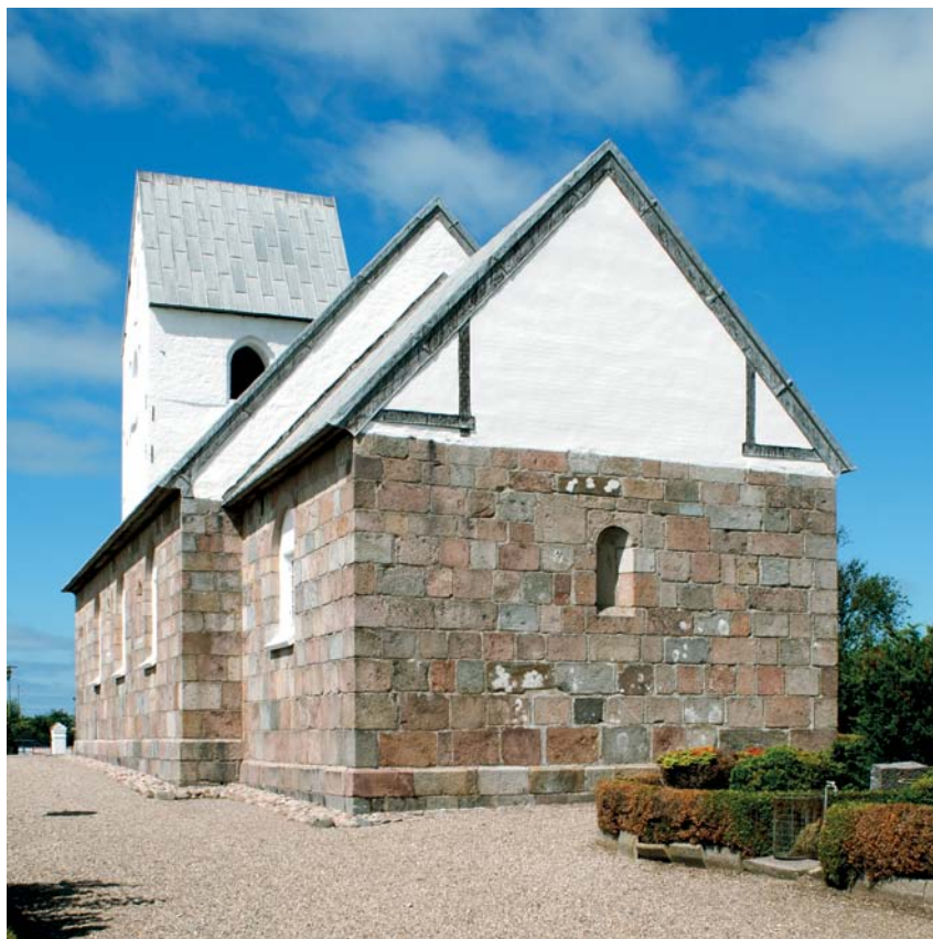
Fig. 10. Ydre set fra sydøst. Foto Hugo Johannsen 2012. – Äußeres aus Südosten.
