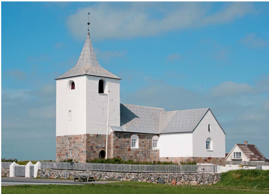
Fig. 1. Ydre set fra sydvest. Foto Hugo Johannsen 2012. – Äußeres aus Südwesten.
