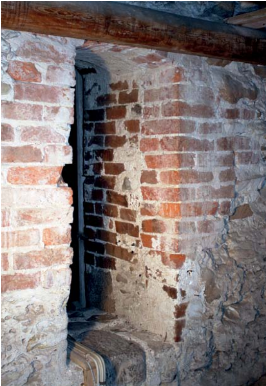
Fig. 41. Døråbning mellem skibets loft og tårnets nedre mellemstokværk (s. 1641). Foto Hugo Johannsen 2012. – Türöffnung zwischen Dachboden des Schiffes und dem niederen Zwischenstockwerk des Turmes.
