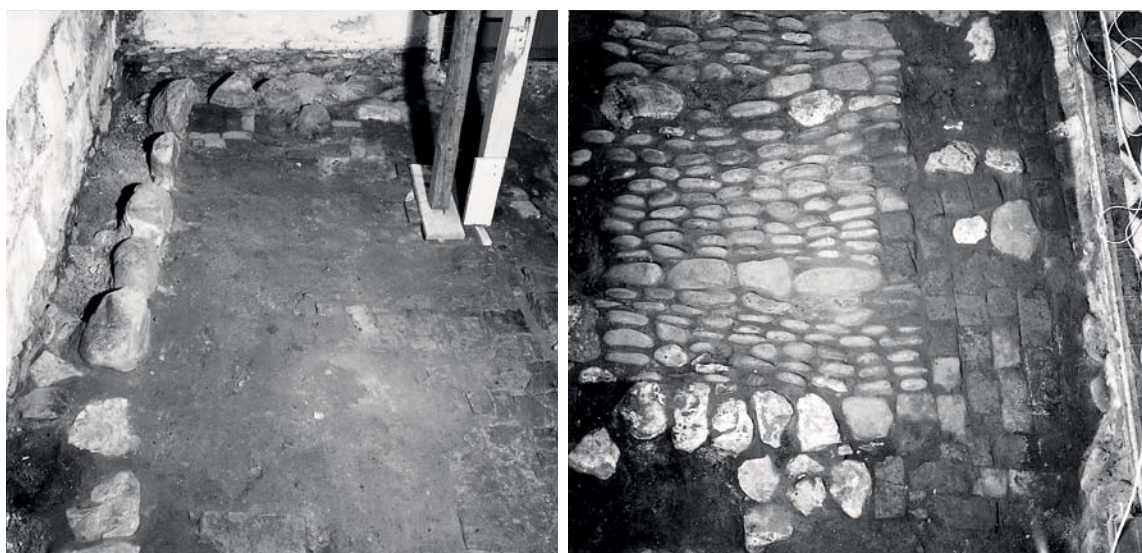
Fig. 17-18. 17. Flisegulv og fundament for tvægbenke i skibets sydvestre hjørne, jf. fig. 16 (s. 1645, 1661). 18. Stenpikning og murstensgulv i skibets nordside, vest for den oprindelige dør, jf. fig. 16 (s. 1645). Foto Morten Aaman Sørensen 1972. – 17. Fliesenboden und Fundament für Wandbänke in der südwestlichen Ecke des Schiffes. 18. Feldsteinboden und Mauersteinboden in der Nordseite des Schiffes, westlich von der ursprünglichen Tür.
