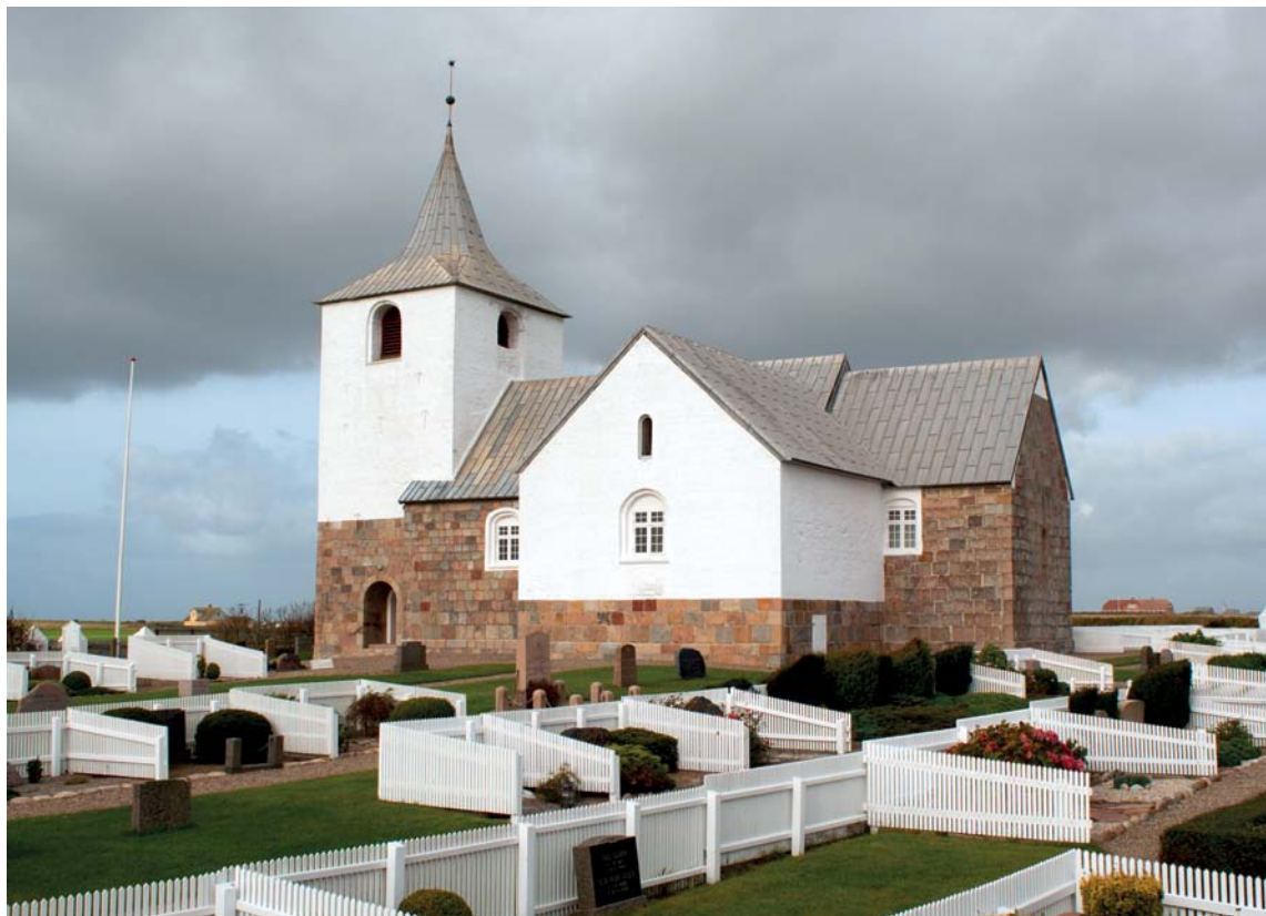
Fig. 8. Ydre set fra sydøst. Foto Hugo Johannsen 2011. – Äußeres aus Südosten.
