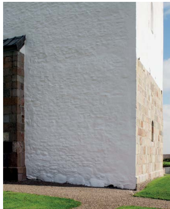
Fig. 13. Detalje af tårnets nord- og vestside med udflyttede granitkvadre (s. 1640). Foto Hugo Johannsen 2012. – Detail von Nord- und Westseite des Turmes mit versetzten Granitquadrern.
