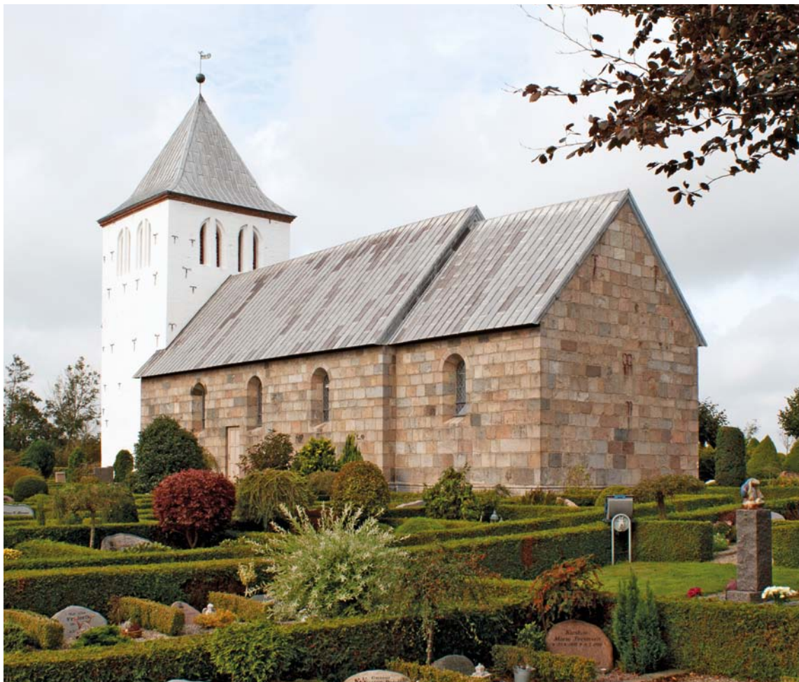
Fig. 1. Ydre set fra sydøst. Foto Hugo Johannsen 2011. – Äußeres aus Südosten.
