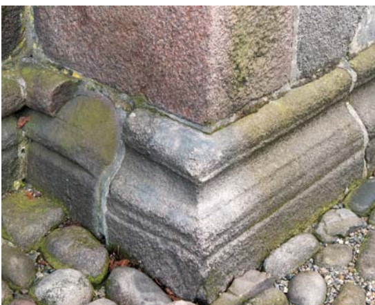
Fig. 13. Sokkel på skibets nordøsthjørne (s. 1733). Foto Hugo Johannsen 2011. – Sockel in der Nordostecke des Schiffes.
