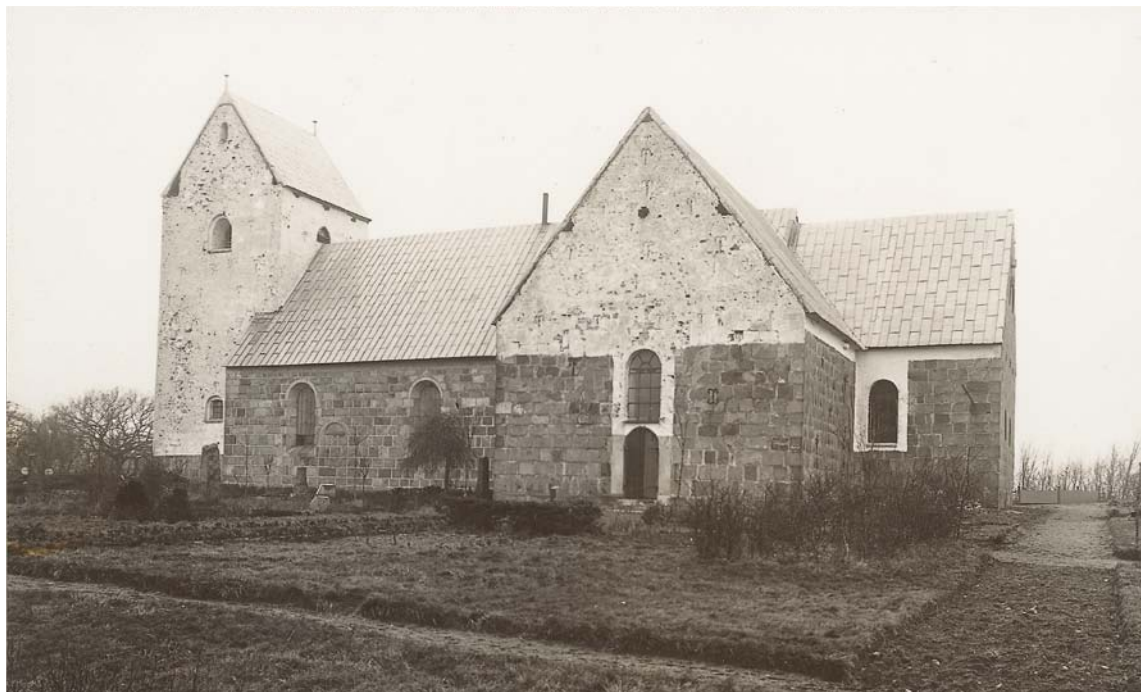
Fig. 73. Ydre set fra sydøst. Ældre foto i NM. – Äußeres aus Südosten.
