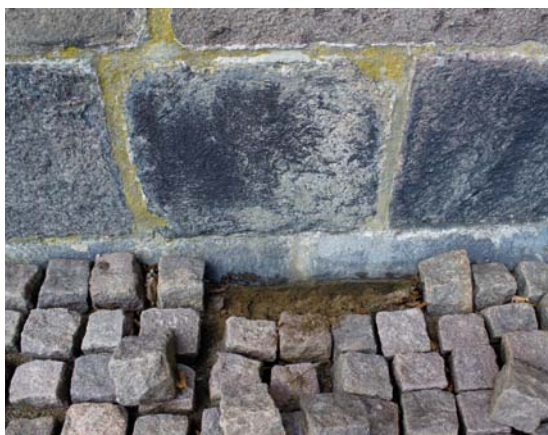
Fig. 75. Skråkantsoklen på skibets nordside (s. 1845). Foto Anders C. Christensen 2013. – Der Schrägganten-sockel an der Nordseite des Schiffes .
