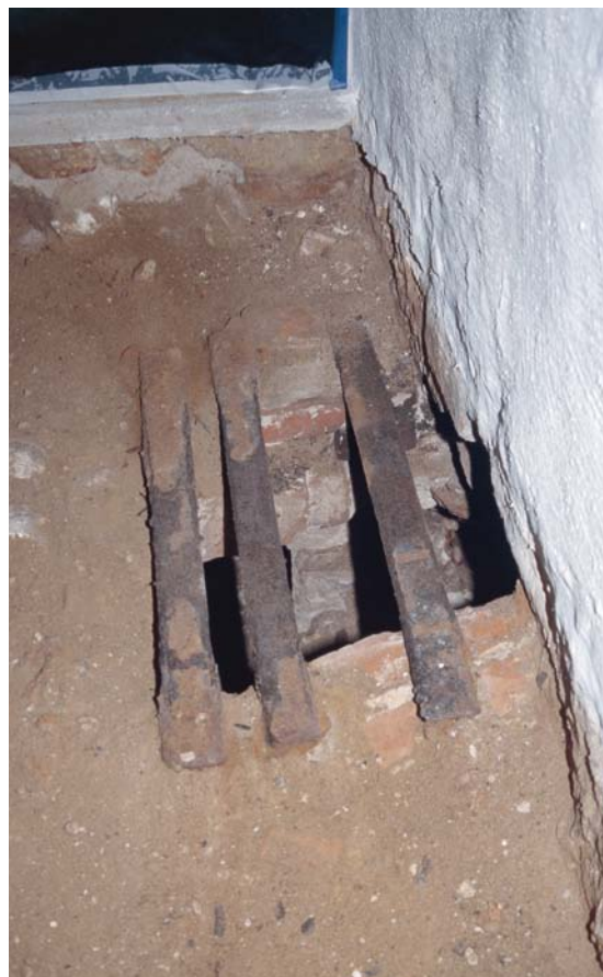
Fig. 72. Nedgang til gravkrypten under koret set fra øst (s. 1855, 1911). Foto Birgit Als Hansen 2005. – Abgang zum (†)gemauerten Begräbnis unter dem Chor, von Ost gesehen.
