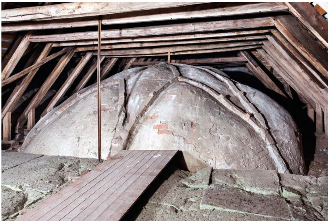
Fig. 19. Korsskæringens hvælv over loftet set fra vest (s. 1852). Foto Arnold Mikkelsen 2013. – Gewölbe der Kreuzung über der Decke von Westen.
