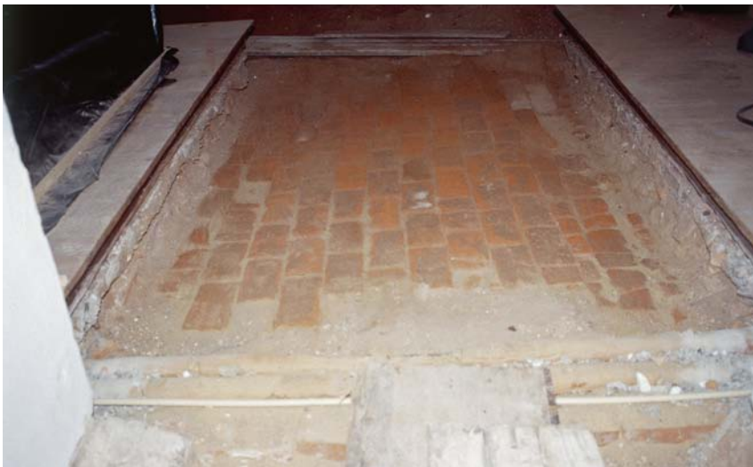
Fig. 21. Ældre teglgulv i skibet (s. 1858). Foto Birgit Als Hansen 2005. – Älterer Ziegelboden im Schiff .
