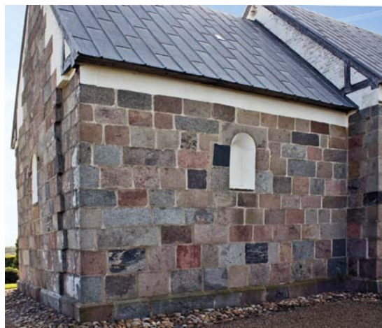
Fig. 62. Korets nordmur. Foto Anders C. Christensen 2012. – Nordmauer des Chores .
