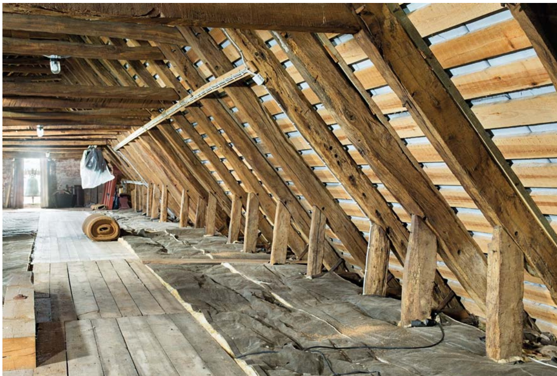
Fig. 13. Nordsiden af kirkens tagværk set fra øst (s. 2126). Foto Arnold Mikkelsen 2014. – Nordseite der Kirchendachwerke aus Osten.
