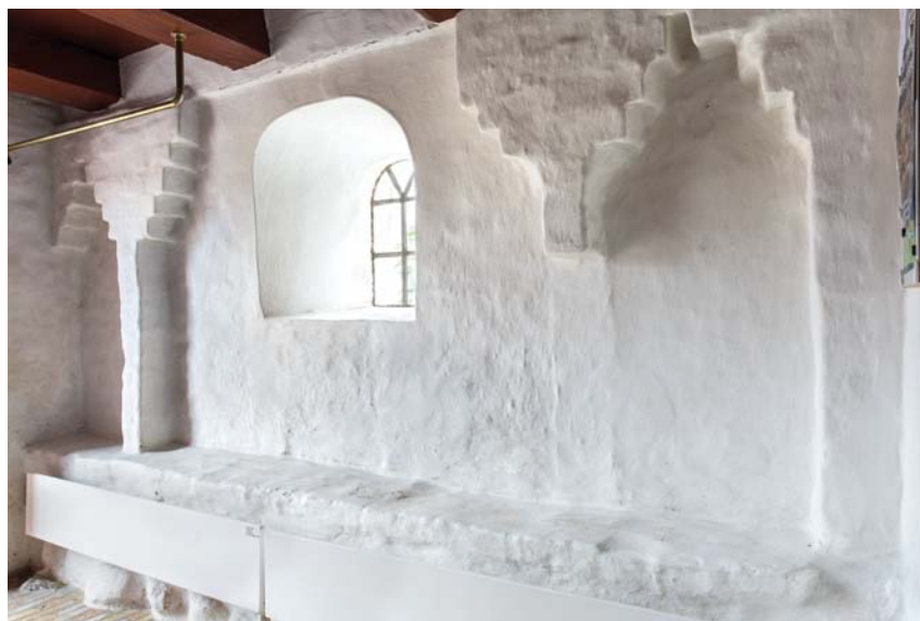
Fig. 12. Väbenhusets indre set fra sydvest (s. 2122). Foto Arnold Mikkelsen 2014. – Das Innere der Vorhalle aus Südwesten.
