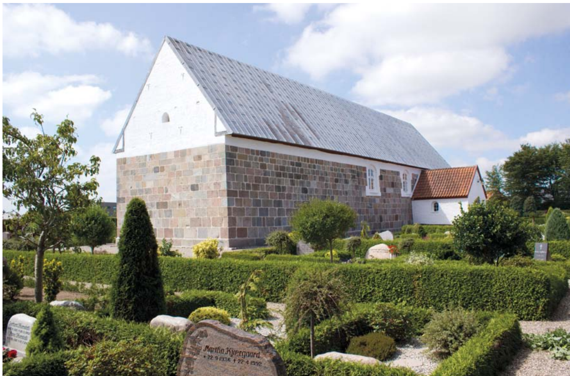
Fig. 5. Ydre set fra nordøst. Foto Anders C. Christensen 2014. – Äußeres aus Nordosten.
