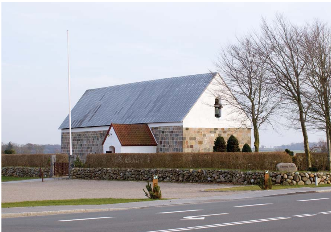
Fig. 1. Ydre set fra nordvest. Foto Anders C. Christensen 2014. – Äußeres aus Nordwesten.
