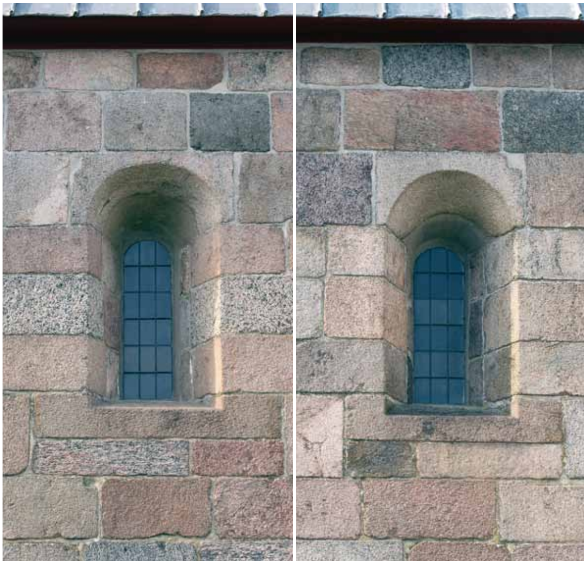
Fig. 18-19. 18. Skibets østre nordvindue (s. 2185). 19. Skibets vestre nordvindue (s. 2185). Foto Anders C. Christensen 2014. – 18. Eastern north window of the nave . 19. Western north window of nave .
