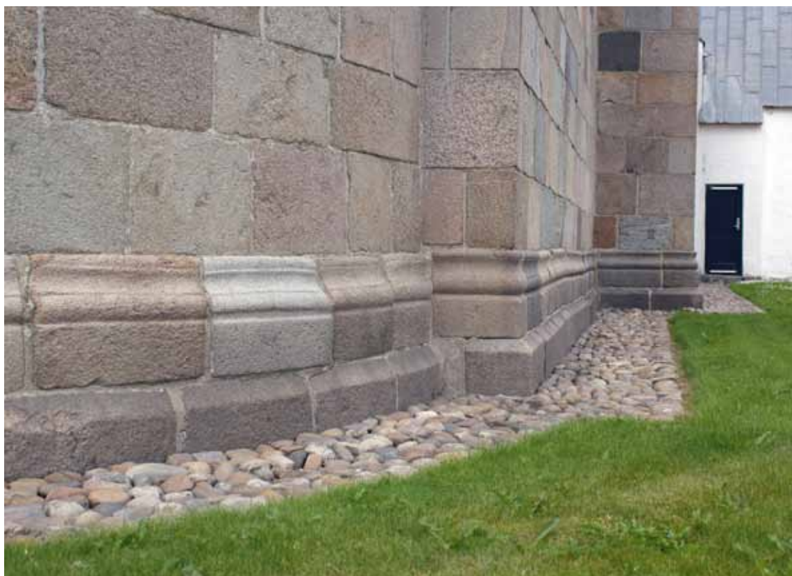
Fig. 98. Dobbelt sokkel på nordsiden (s. 2180). Foto Anders C. Christensen 2014. – Double footing on the north side.
