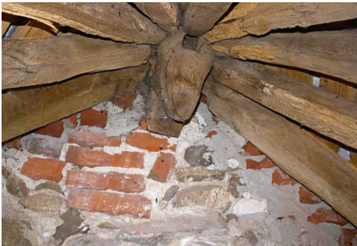
Fig. 32. Detalje af apsidens tagværk (s. 2197). Foto Anders C. Christensen 2014. – Detail of apse roofing.
