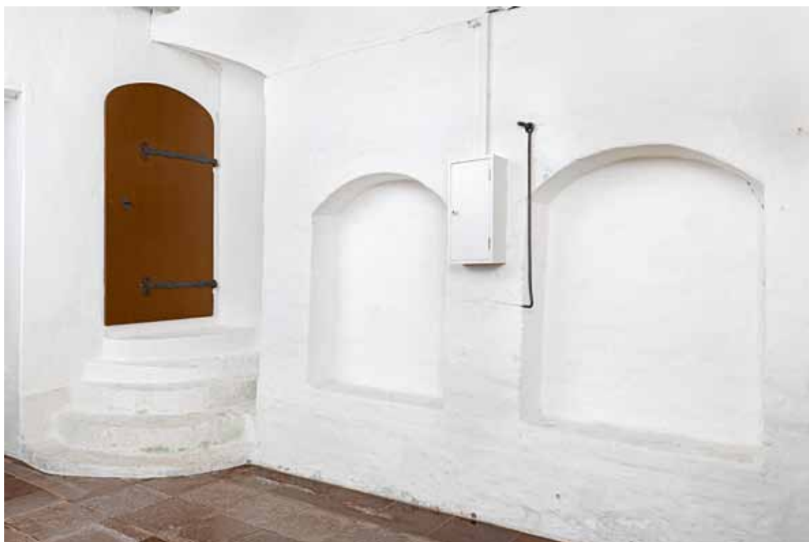
Fig. 22. Våbenhusets indre set mod sydvest (s. 2188). Foto Arnold Mikkelsen 2014. – Interior of porch looking south west .
