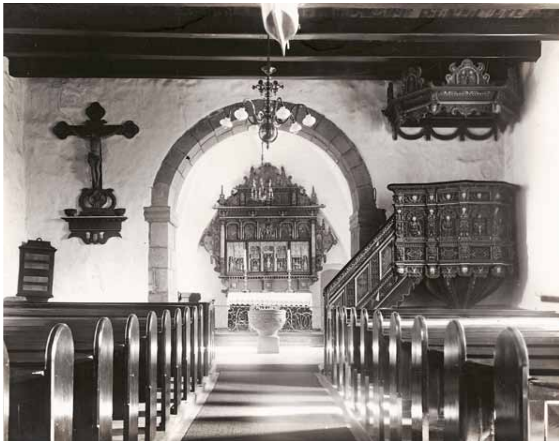
Fig. 35. Indre, set mod øst. Ældre foto (før 1936). – Interior looking east.
