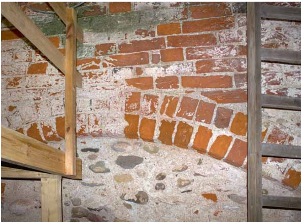
Fig. 14. Udsnit af tårnmurens aflastningsbue set fra vest (s. 2322). Foto Anders C. Christensen 2015. – Detail of relieving arch of tower wall seen from the west.
