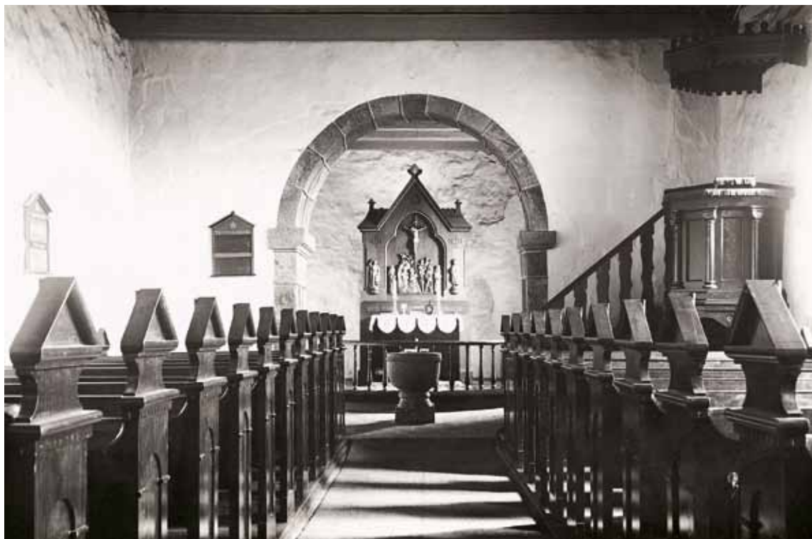
Fig. 19. Indre set mod øst. Foto i NM, 1924 – Interior looking east, 1924.
