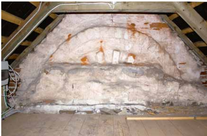
Fig. 12. Våbenhusets gavlf set fra loftet (s. 2321). Foto Anders C. Christensen 2015. – Gable of the porch seen from the ceiling.
