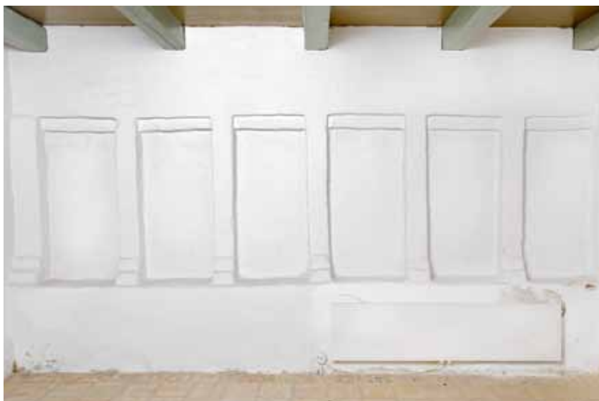
Fig. 19. Nicher i våbenhusets vestvæg (s. 2361). Foto Arnold Mikkelsen 2014. – Niches in the west wall of the porch.
