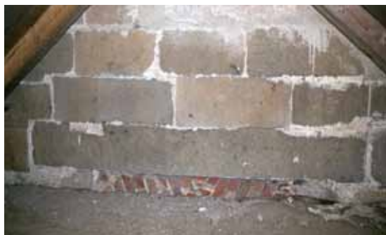
Fig. 58. Monolitoverligger over skibets norddør (s. 2357). Foto Anders C. Christensen 2016. – Monolithic lintel above north door of nave.
