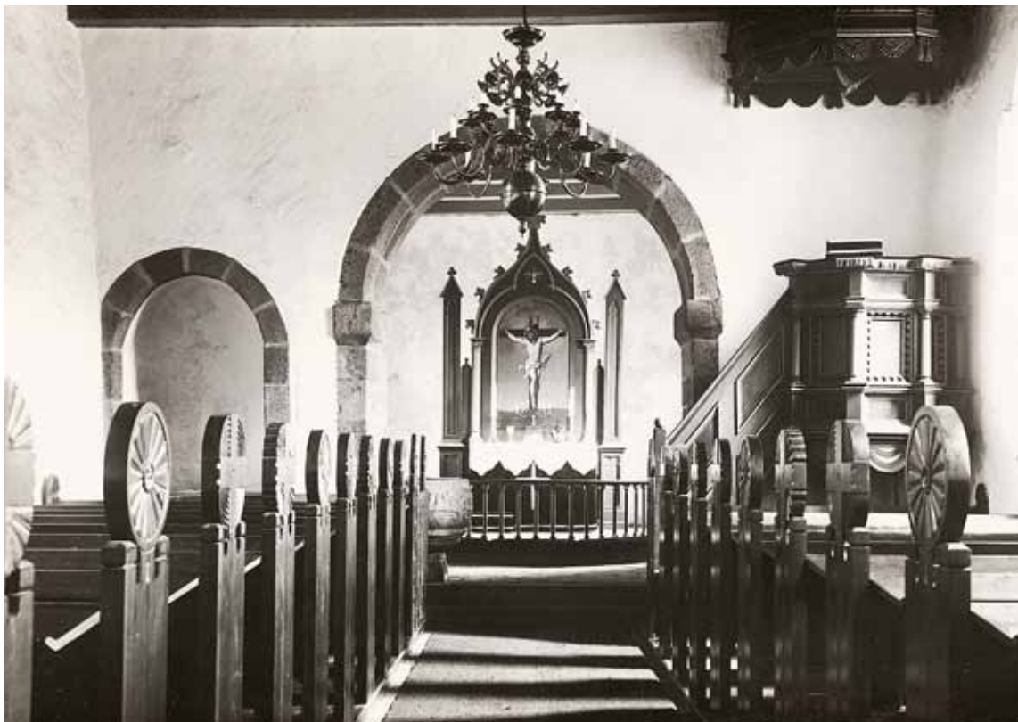
Fig. 28. Indre mod øst, efter restaureringen 1919. Foto i NM. – Interiore looking east, after restoration 1919.
