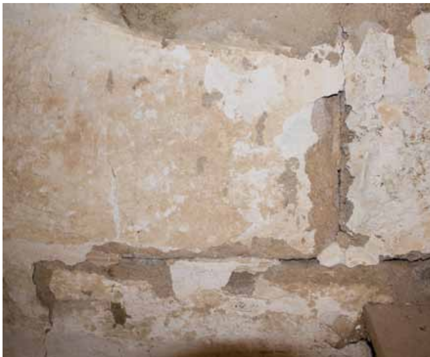
Fig. 48. Detalje af skibets kvaderbeklædning over våbenhusets loft (s. 2404). Foto Anders C. Christensen 2016. – Detail of ashlar cladding of nave above porch ceiling.
