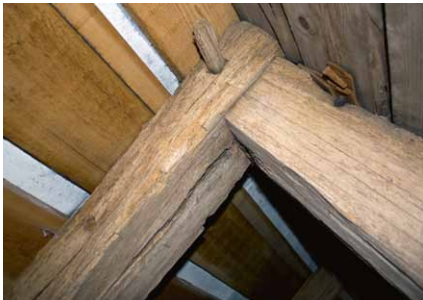
Fig. 13. Detalje af skibets tagværk (s. 2456). Foto Anders C. Christensen 2015. – Detail of roofing of nave.
