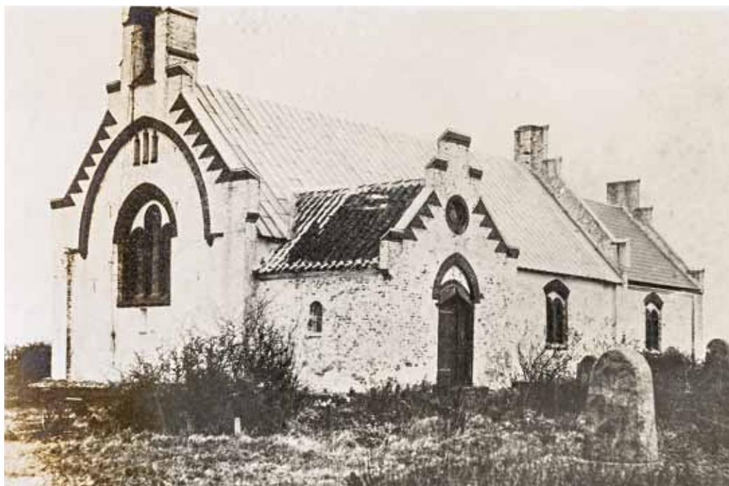
Fig. 12. Kirkens ydre, set fra sydvest. Efter ældre fotografi i kirkens eje. – Exterior seen from the south west.
