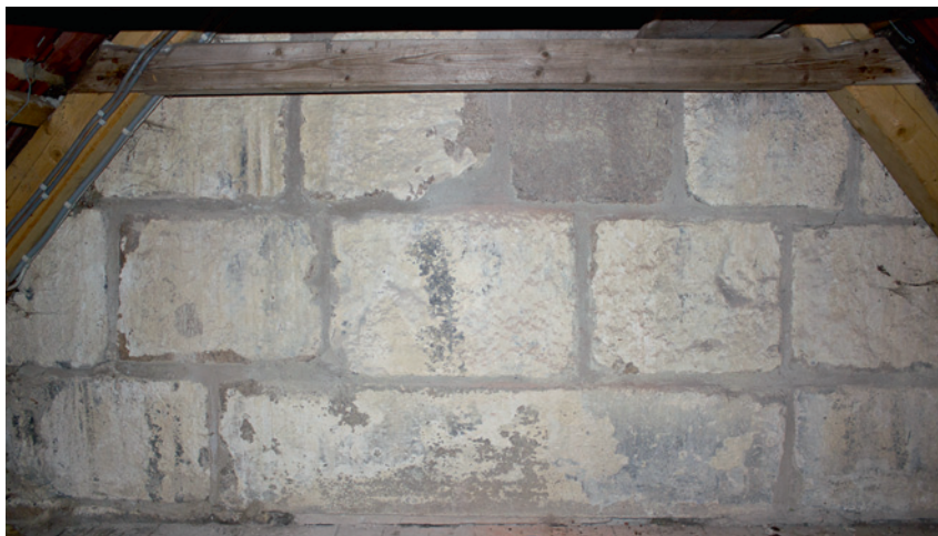
Fig. 48. Skibets facade over våbenhusets loft set fra syd (s. 2485). Foto Anders C. Christensen 2016. – Facade of nave above ceiling seen from the south.
