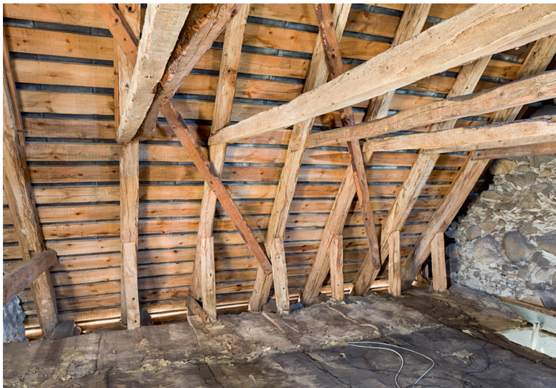
Fig. 21. Korets tagværk set mod syd (s. 2488). Foto Arnold Mikkelsen 2016. – Roofing of chancel looking south.
