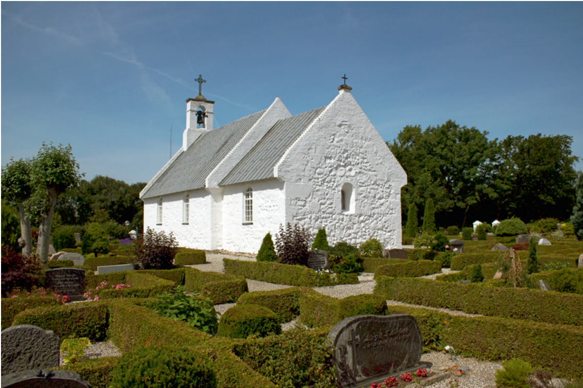
Fig. 6. Ydre set fra sydøst. Foto Anders C. Christensen 2013. – Exterior seen from the south east.
